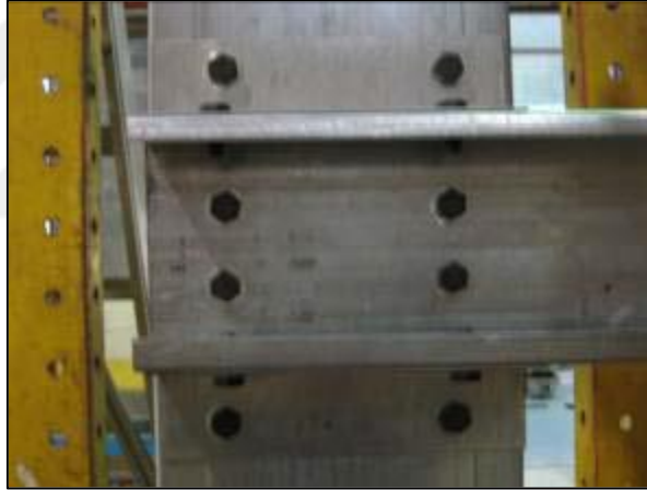
Şekil 2.20. Hafif çelik yapılarda bulonlu birleşim(Hazlan vd. 2010)
