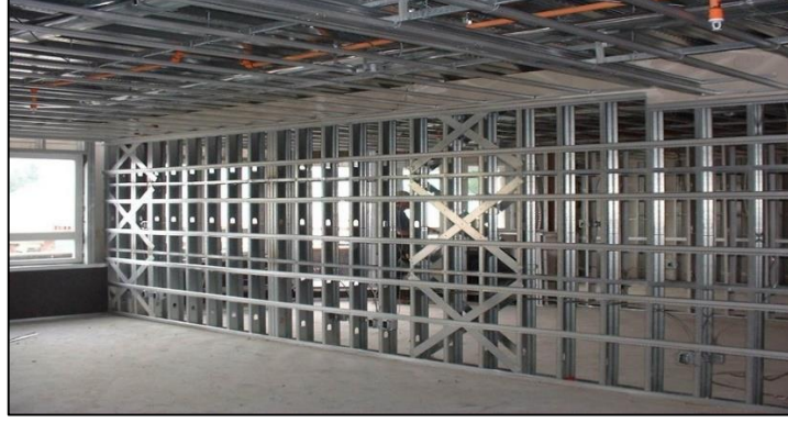
Şekil 2.13. Hafif profil duvar elemanları
