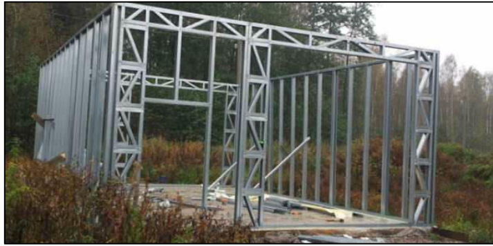
Şekil 2.12. Hafif çelik profil makas birleşimleri
