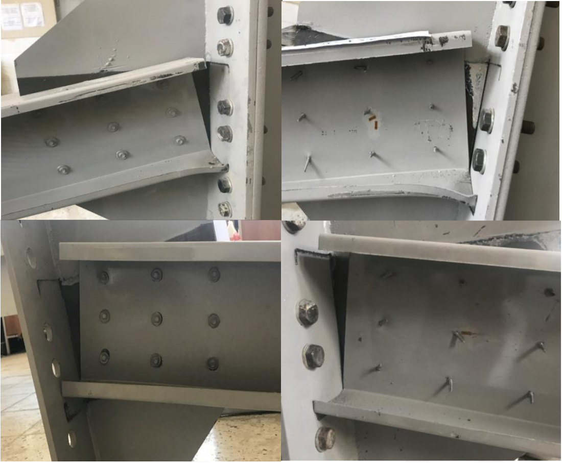
Şekil 2.28. Vidalı kiriş-kolon birleşiminin göçme modları (Maali vd. 2017)
