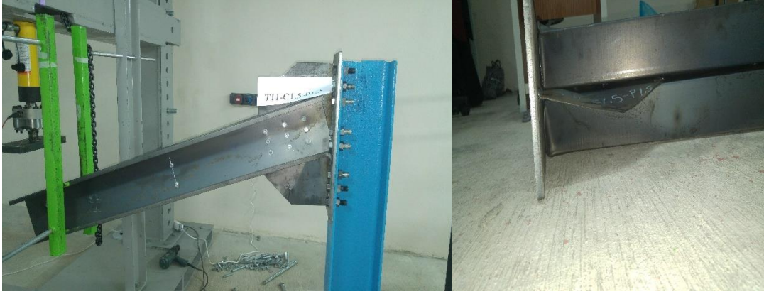
Şekil 4.35. T11-C1.5-P1.5 kirişinin göçme modu
