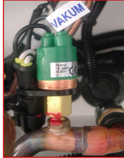
Şekil 1.25 Klima sisteminde alçak basınç otomatığı genel görünüşü.
