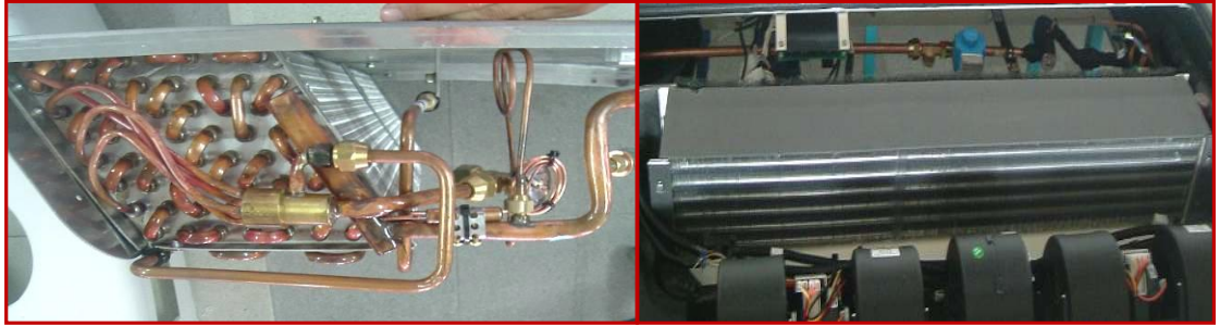
Şekil 1.13 Evaporatör peteği ve genişleme valfi kompleksi.
