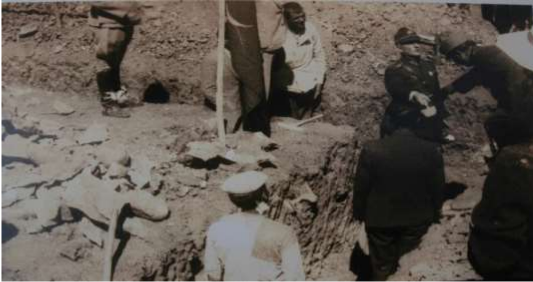
Resim 3.2. Kışla binasının temel atma çalışması. (Tunceli İl Kültür Müdürlüğü Arşivi)
