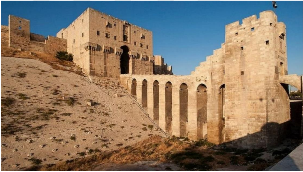
Kalenin köprülü girişi ve iç kapı 909
