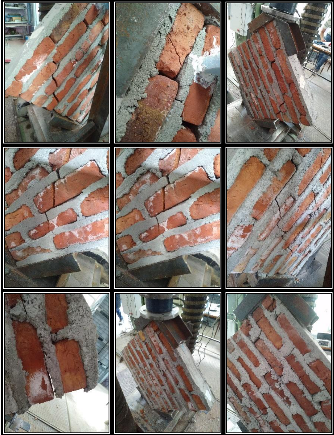
Şekil E1.3. D1L1O3 tip duvarlara ait hasar fotoğrafları
