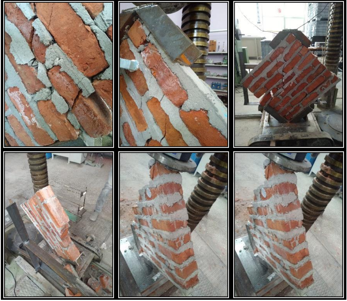
Şekil E1.12. D1NH03 tip duvarlara ait hasar fotoğrafları
