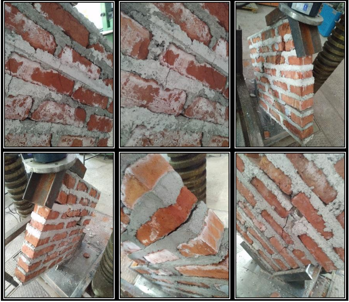
Şekil E1.20. D2L3O2 tip duvarlara ait hasar fotoğrafları
