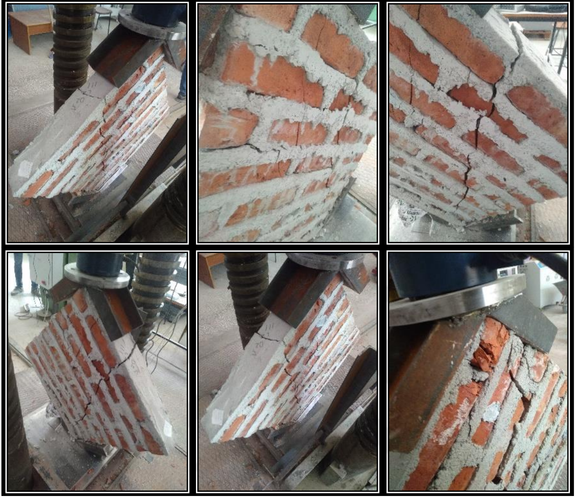
Şekil E1.18. D2L2O3 tip duvarlara ait hasar fotoğrafları
