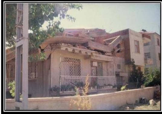
Dinar depreminde (1995) hasar gören, üst katı boşluklu tuğla ile imal edilmiş yığma yapı [25]
