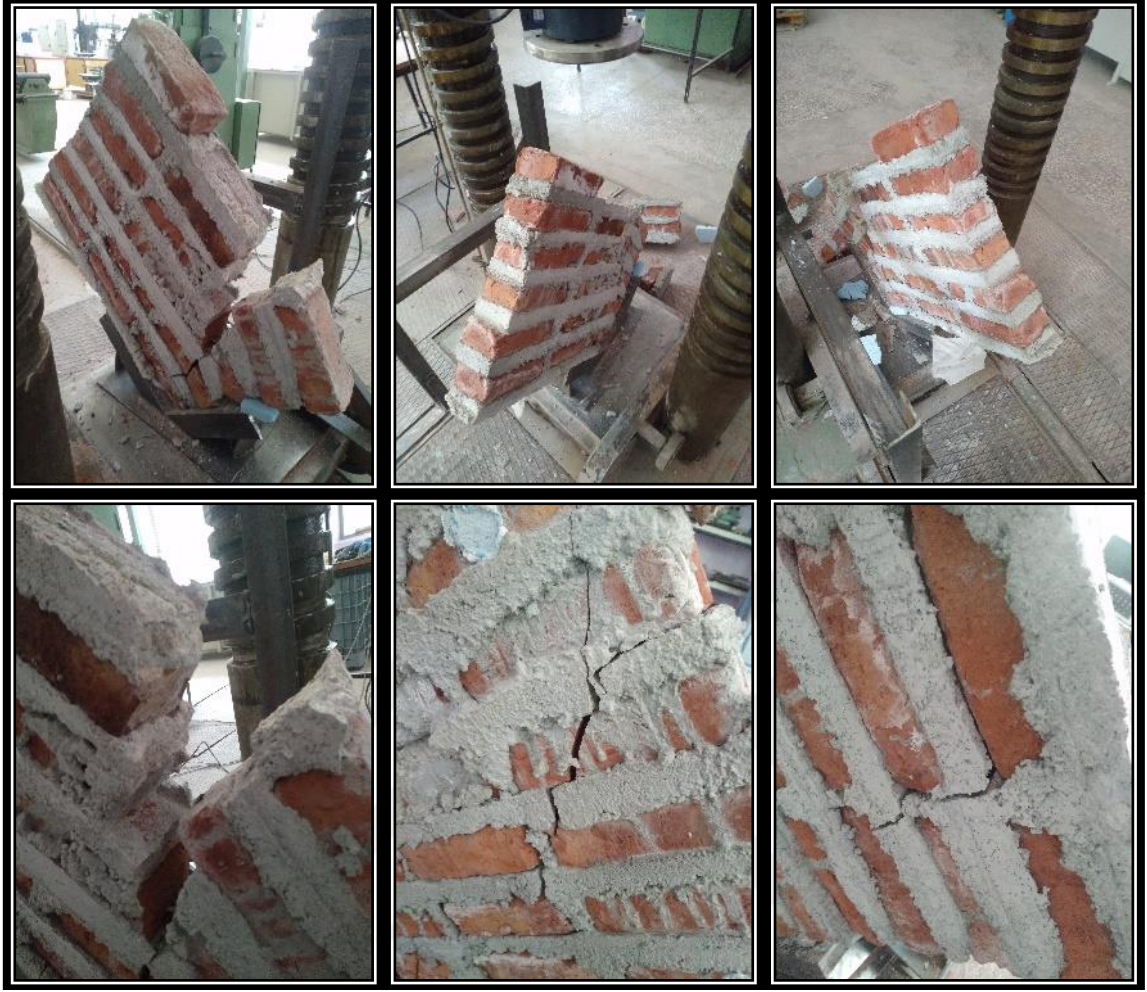
Şekil E1.25. D3L1O1 tip duvarlara ait hasar fotoğrafları
