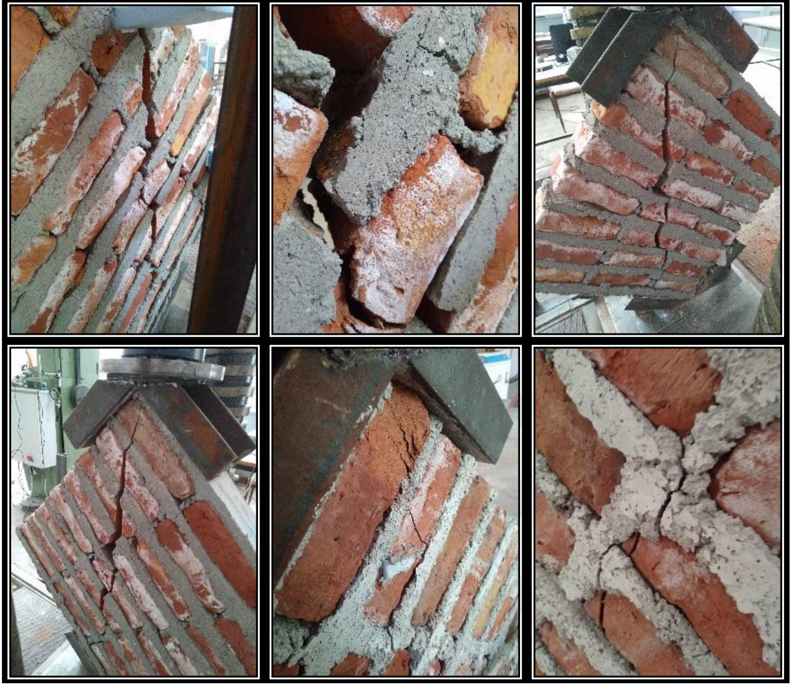
Şekil E1.19. D2L3O1 tip duvarlara ait hasar fotoğrafları
