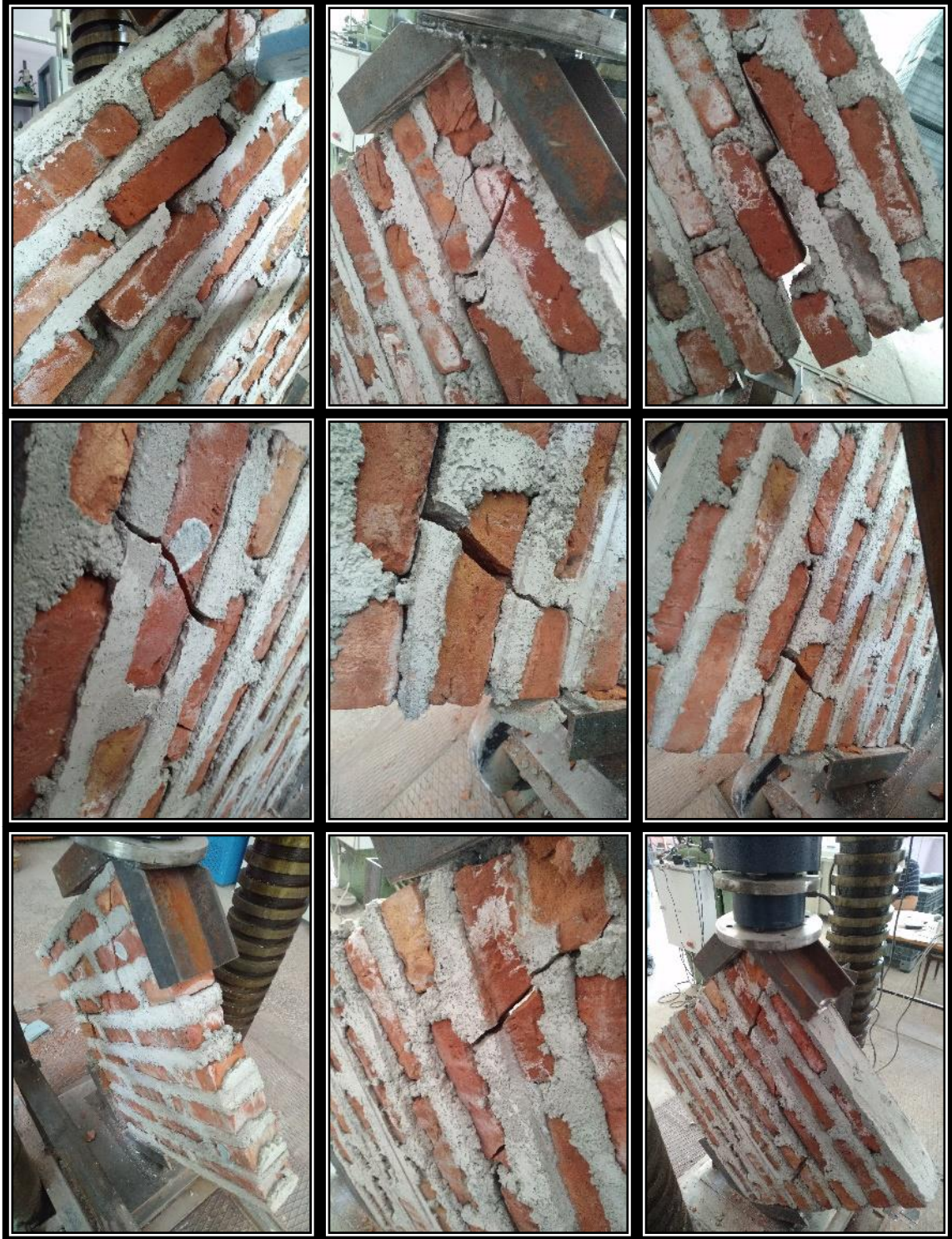
Şekil E1.14. D2L1O2 tip duvarlara ait hasar fotoğrafları
