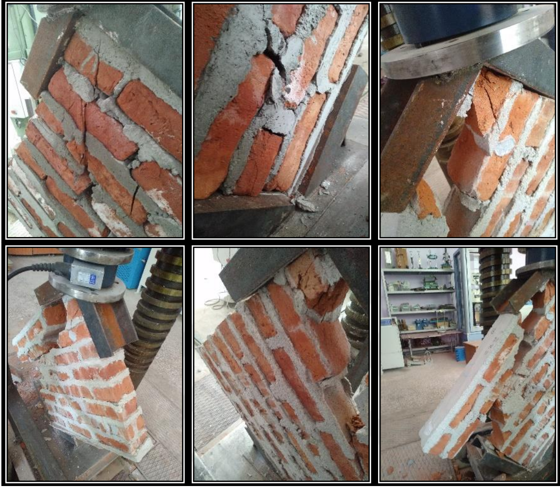
Şekil E1.11. DINHO2 tip duvarlara ait hasar fotoğrafları
