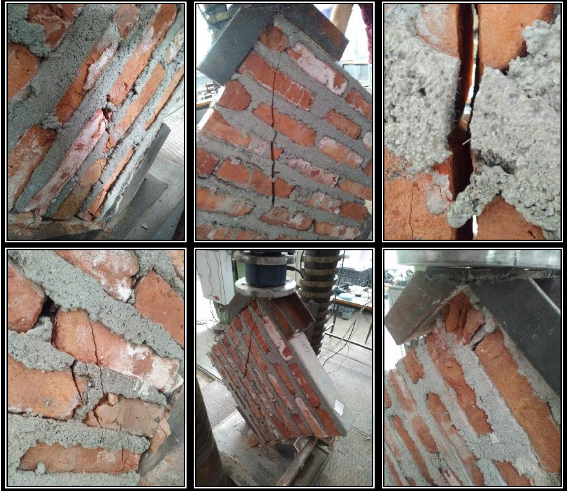
Şekil E1.6. D1L2O3 tip duvarlara ait hasar fotoğrafları
