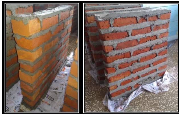
Şekil 6.17. Yığma duvar elemanlarına kür işleminin yapılması
