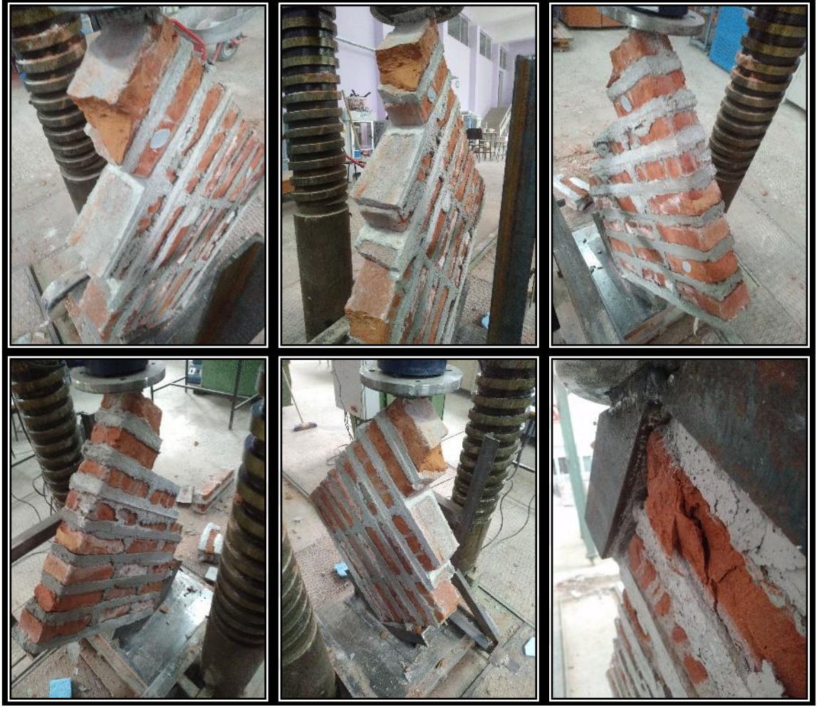
Şekil E1.34. D3NHO1 tip duvarlara ait hasar fotoğrafları
