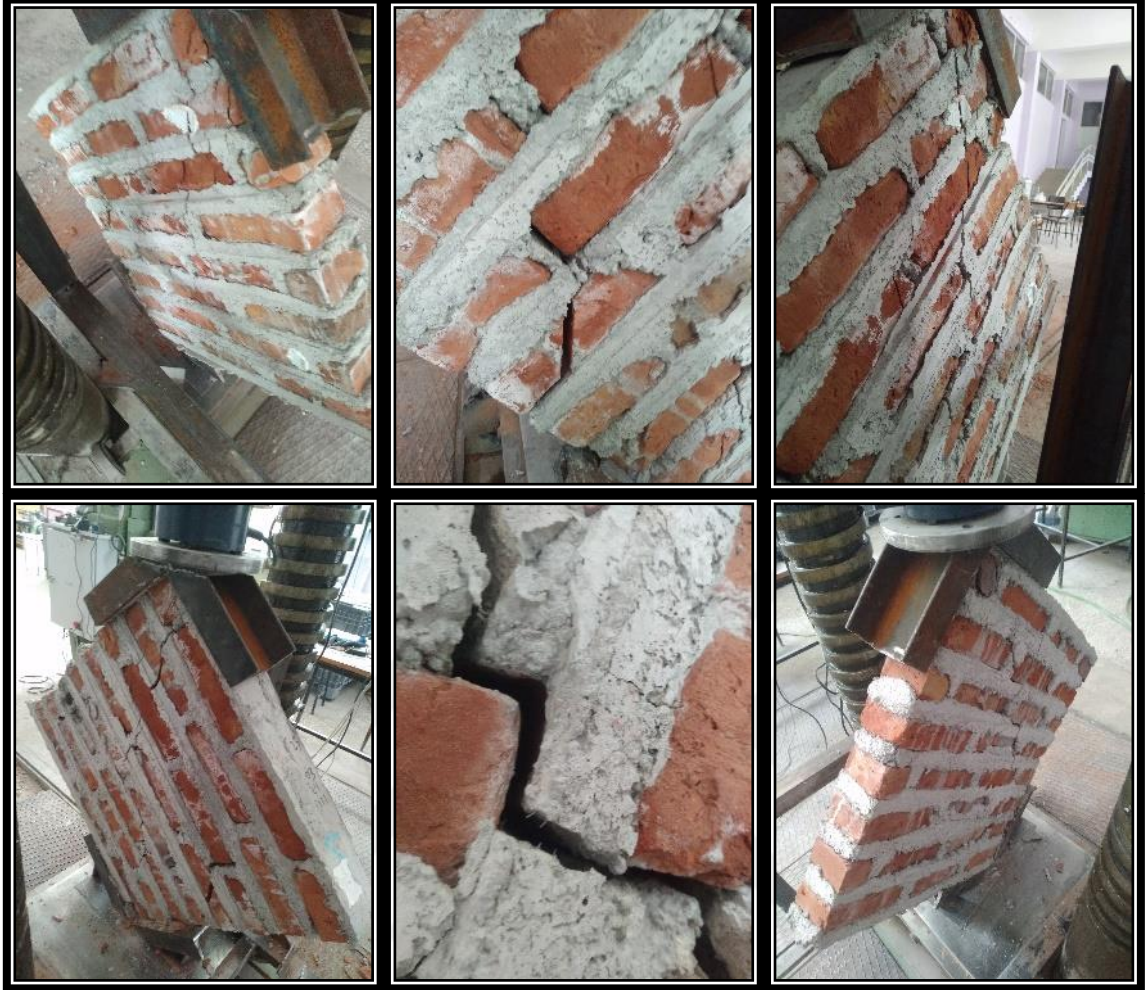
Şekil E1.27. D3L1O3 tip duvarlara ait hasar fotoğrafları
