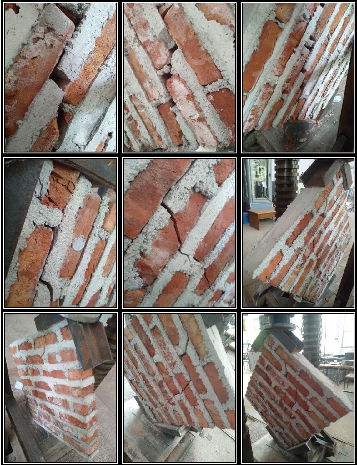
Şekil E1.15. D2L1O3 tip duvarlara ait hasar fotoğrafları
