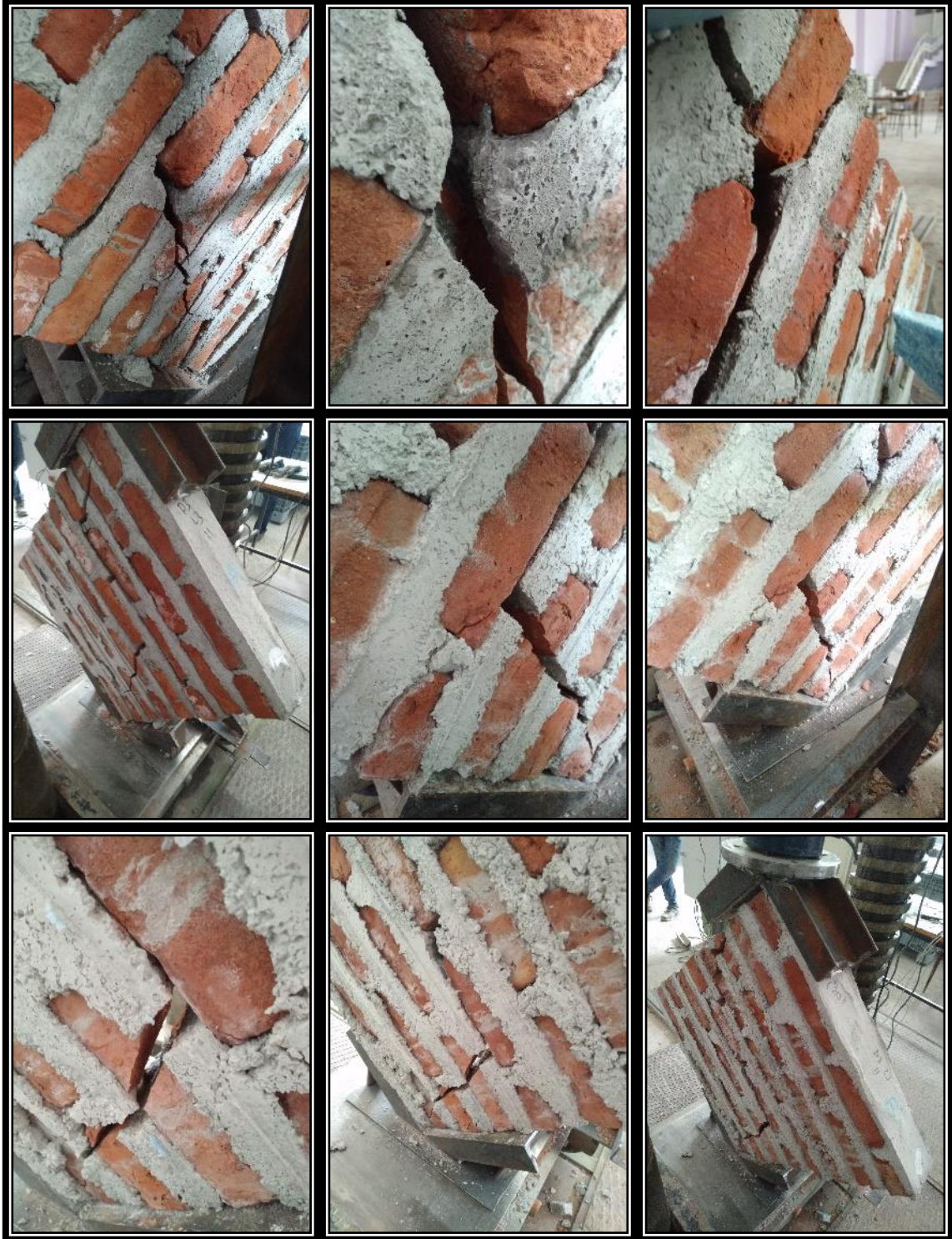
Şekil E1.32. D3L3O2 tip duvarlara ait hasar fotoğrafları
