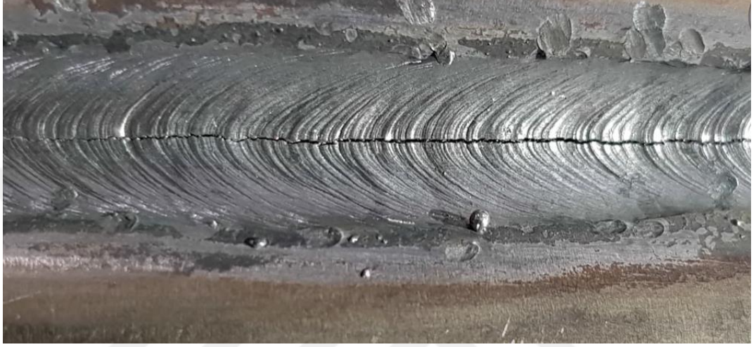
Şekil 2.9. Kaynakta çatlak hatası.
