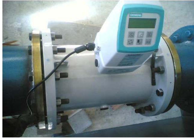
Şekil 5.4. Giriş debisi ölçen elektromanyetik debimetre
