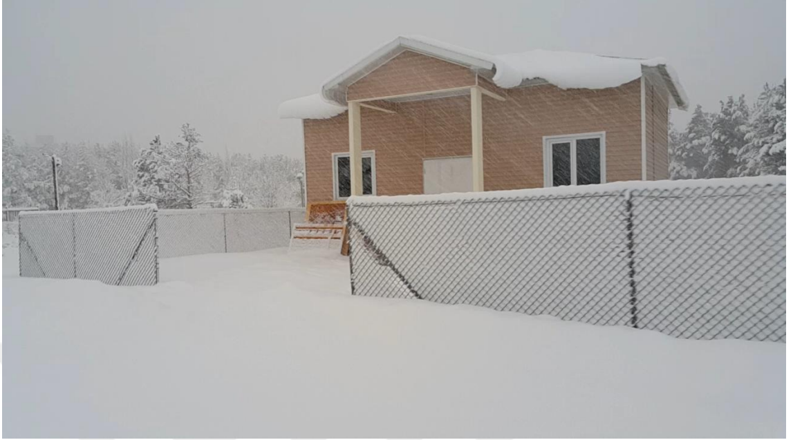
Şekil 5.2. Kış şartlarında pilot ölçekli MBR tesisi
