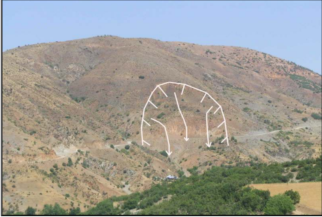
Foto 125: Oymaağaç ile Sarıbük köyü arasındaki karayolu üzerinde yüksek taban suyu nedeniyle oluşan heyelan alanı.
