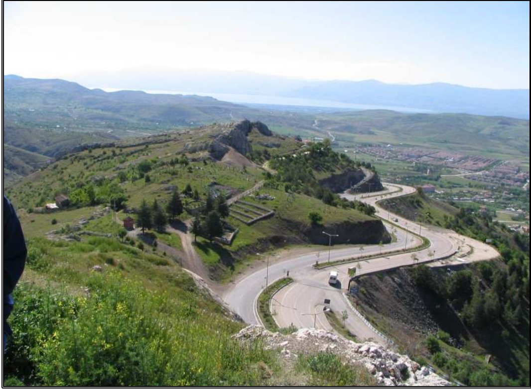
Foto 103: Elazığ-Harput karayolu bağlantısı.
