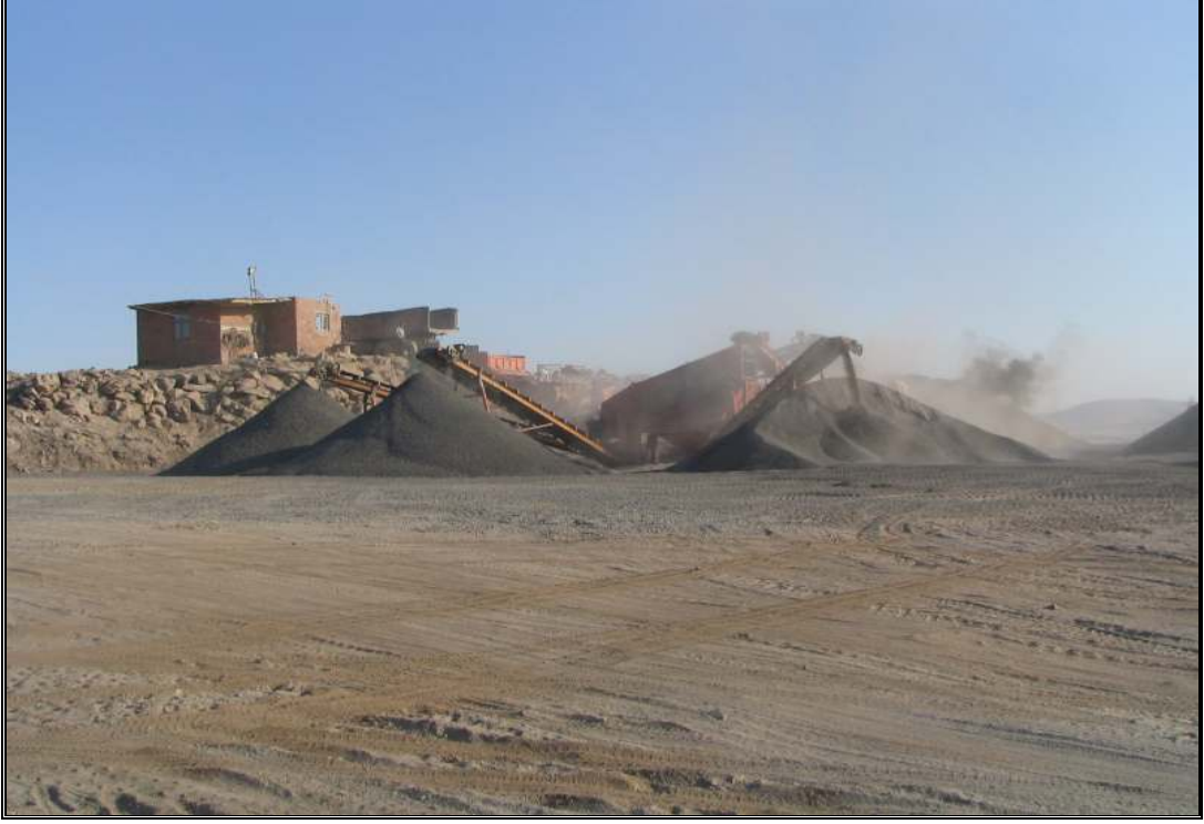
Foto 114: Şahinkaya köyünün kuzeydoğusundaki Karayazı Bazalt Platosu üzerinde bulunan ve bu alandaki bazaltların kırılarak mıcır yapıldığı ocak.
