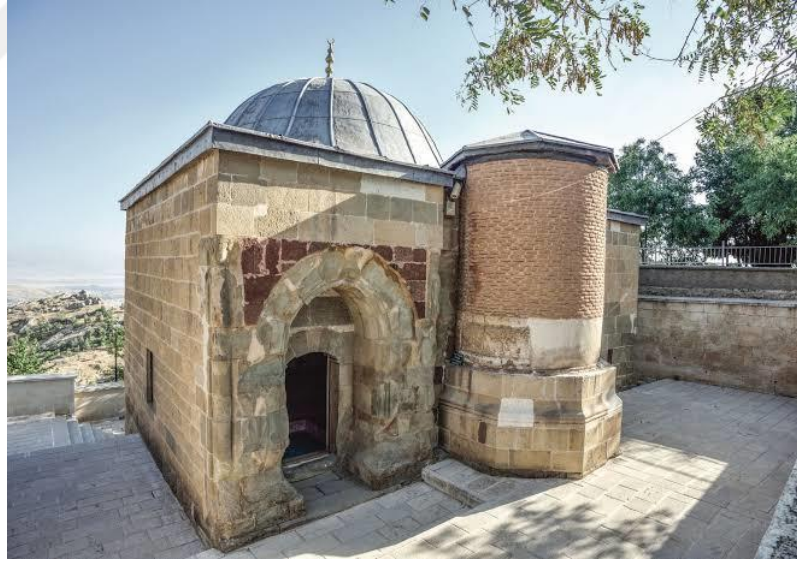
Şekil 4.27 Arap Baba Türbesi [57]
