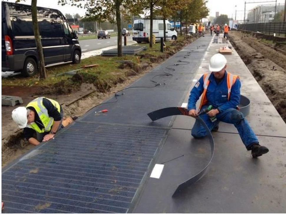
Şekil 5.4 Güneş paneli bisiklet yolu sistemi yapım aşaması [70]
