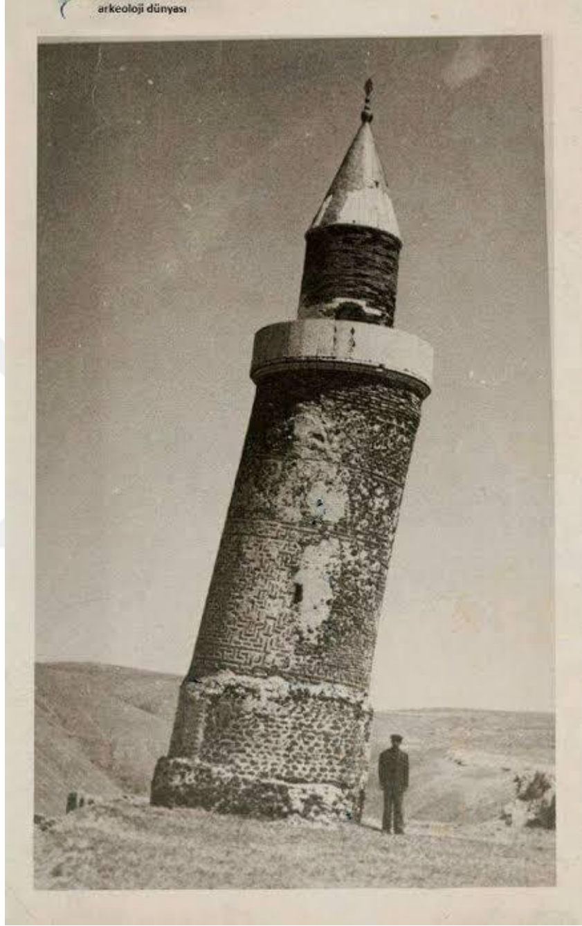
Şekil 4.42 Harput Ulu Camii eğik minare [66]
