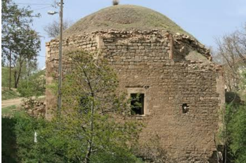
Şekil 4.21 Hoca Hasan Hamamı [62]
