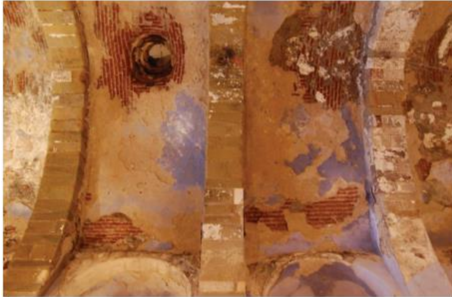
Resim 2.11: Kilisenin Tonozundaki Taş Kemerler ve Tuğla Tonozlar Kaynak: Keser-Kayaalp, 2016: 196.
