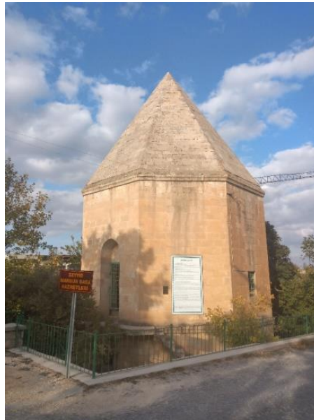
Resim 2.23: Harput Mansur Baba Türbesi Kaynak: Fotoğraf Araştırmacı Tarafından Çekilmiştir, 2019.
