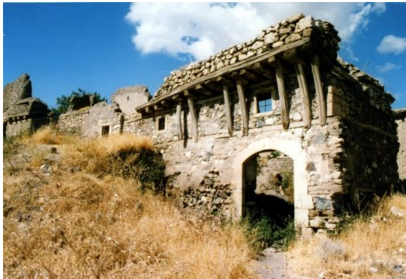
Resim 2.3: Kapı ve Pencereelerde Kullanılan Ahşap Hatıllar
