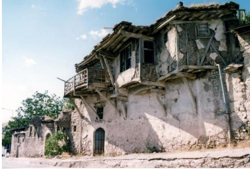
Resim 2.4: Kapı ve Pencereelerde Kullanılan Ahşap Hatıllar
