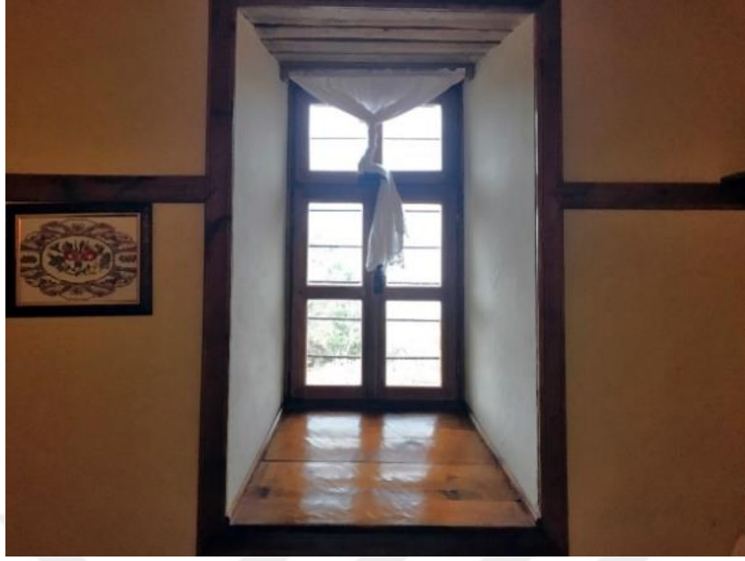
Resim 2.5: Harput Evlerinde Pencere ve Çıkma Örneği Kaynak: Fotoğraf Araştırmacı Tarafından Çekilmiştir, 2019.
