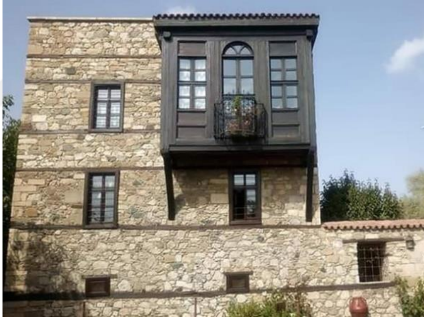
Resim 2.6: Harput Evlerinde Pencere ve Çıkma Örneği Kaynak: Fotoğraf Araştırmacı Tarafından Çekilmiştir, 2019.
