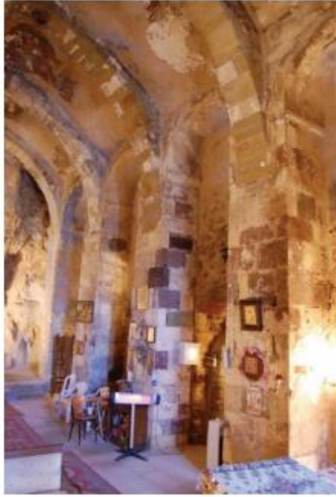
Resim 2.10: Meryem Ana Kilisenin Kuzey Duvarındaki Payeler Kaynak: Keser-Kayaalp, 2016: 195.
