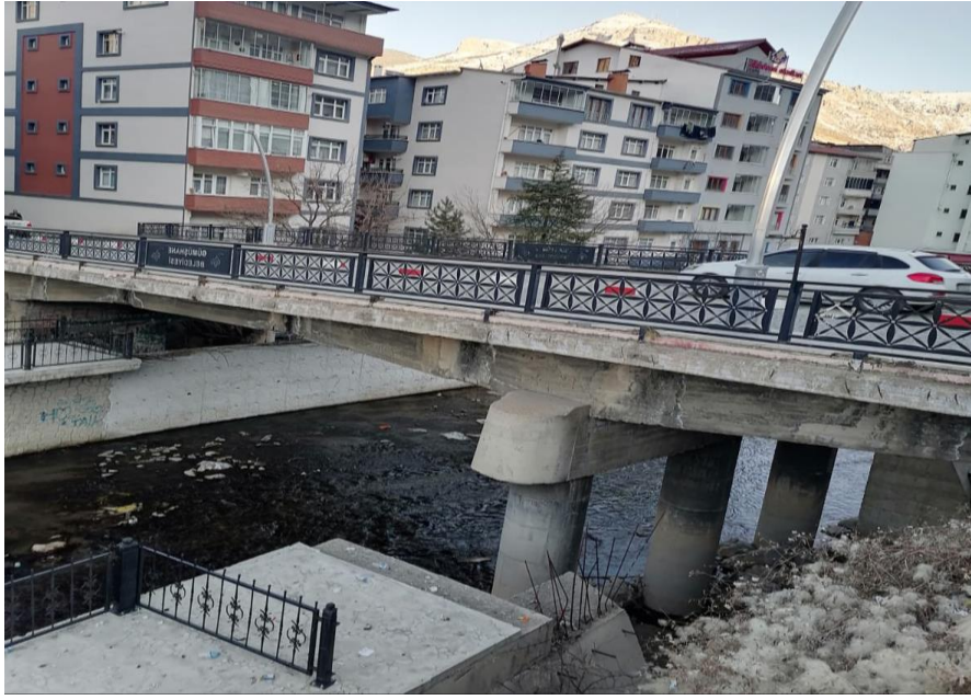
Şekil 30. Çağrı Merkezi Köprüsü mansap görünümü
