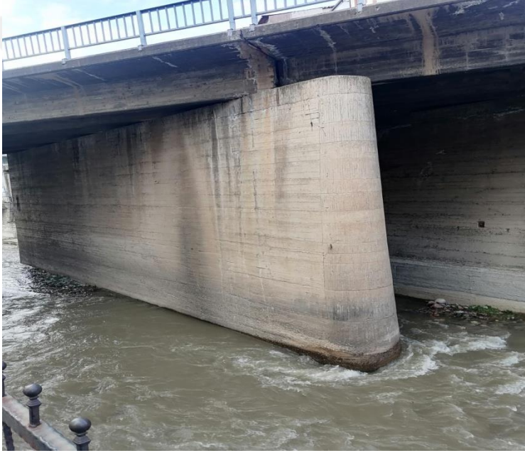
Şekil 14. Harşit Çayı üzerinde yer alan ve akıma yuvarlak burunlu bir yüzey sunan köprü ayağı örneği, Gümüşhane şehir geçişi, Karşıyaka Mahallesi mevkiinde yer alan köprü ayağı
