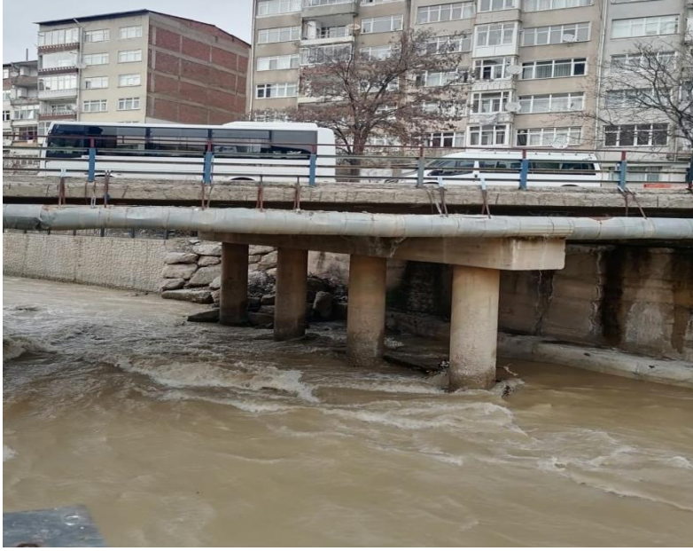
Şekil 15. Harşit Çayı üzerinde yer alan dairesel/silindirik burunlu ayak tipi köprü ayağı örneği, Gümüşhane Merkez, 15 Şubat Caddesi Köprüsü
