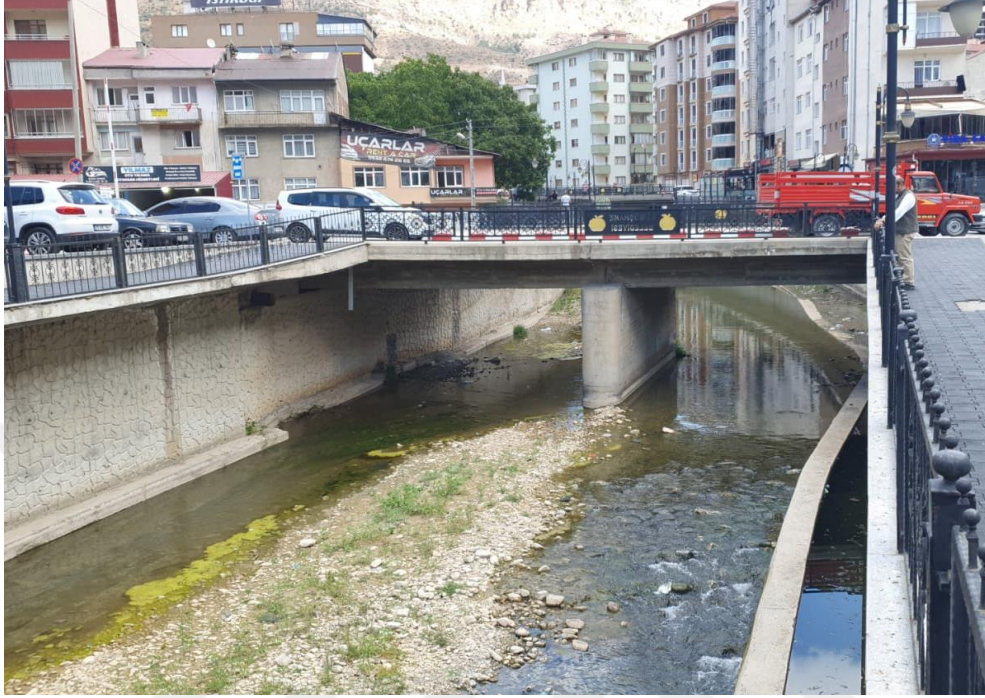
Şekil 28. Hürriyet Caddesi Köprüsü mansap görüntüsü
