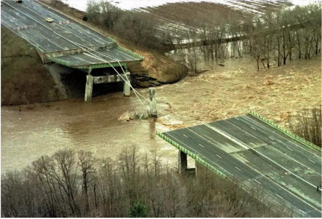
Şekil 5. Schoharie Köprüsü, NewYork
