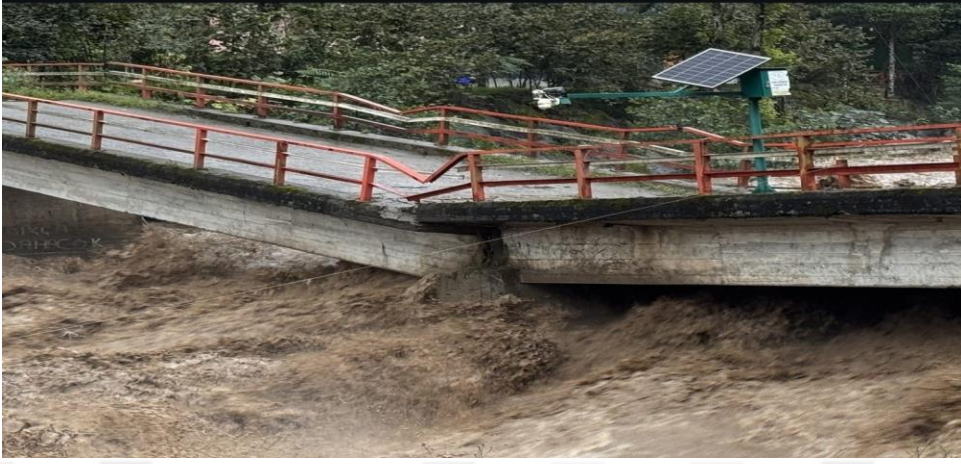
Şekil 4. Rize’de 2025 yılındaki taşkın sonrası hasar gören bir köprü kesiti. (GZT Dijital Haber, 2025)
