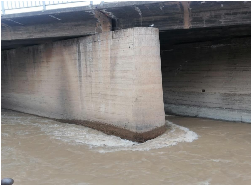
Şekil 27. E97 karayolu ağının Gümüşhane şehir geçişinde yer alan ve Karşıyaka mahallesini şehir merkezine bağlayan ana köprü ayak ve akış etkileşimi görüntüsü
