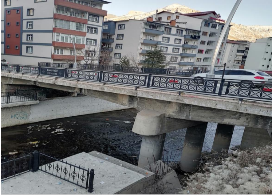
Şekil 30. Çağrı Merkezi Köprüsü mansap görünümü
