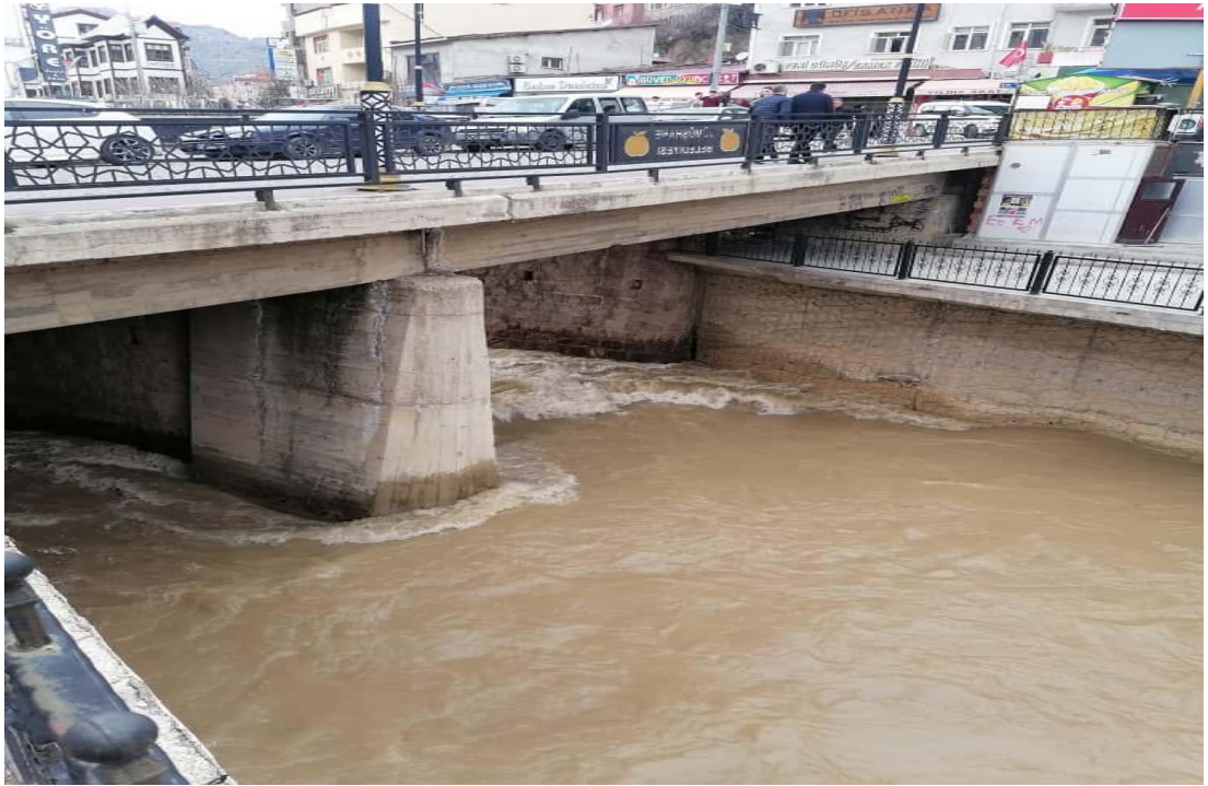
Şekil 37. RS 900 köprünün genel görünümü ve farklı geometriye sahip iki orta ayağı (solda yuvarlak burunlu, sağda kare burunlu )
