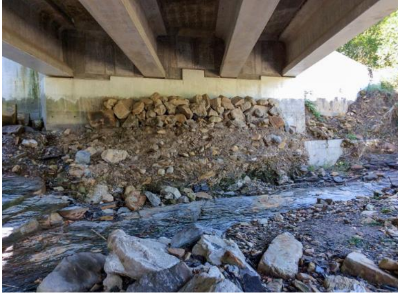
Şekil 17. Köprü ayağı çevresinde oyulmaya karşı uygulanan kaya dolgu (riprap) zırhlanma örneği (Sears, 2024).
