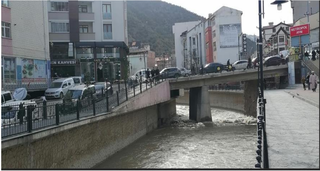
Şekil 39. RS 900 Yuvarlak burunlu köprü ayağının görünümü
