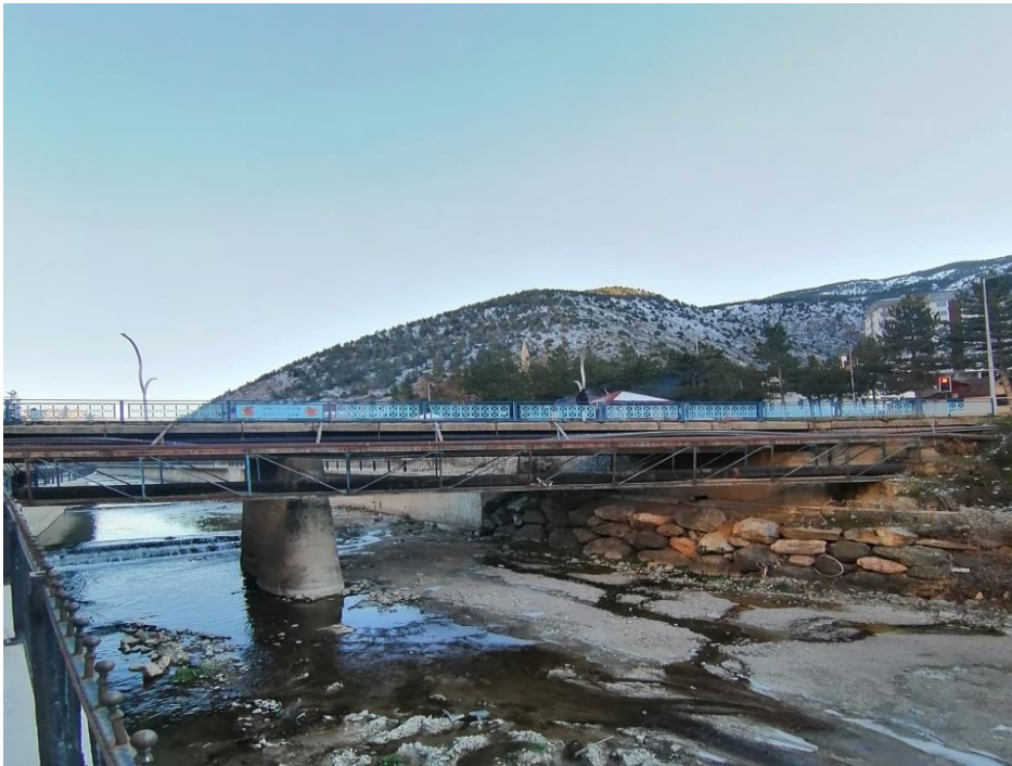
Şekil 31. Eski hastane köprüsü genel görünümü
