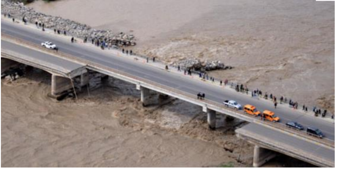
Şekil 2. Zonguldak, Çaycuma, 2012 (Çaycuma Köprüsü Raporu, 2012)
