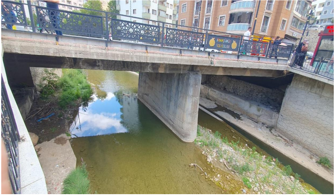
Şekil 36. Modeldeki RS 700 Numaralı Köprünün Düşük Akım Koşullarındaki Görünümü ve Köprü Ayağı Geometrisi
