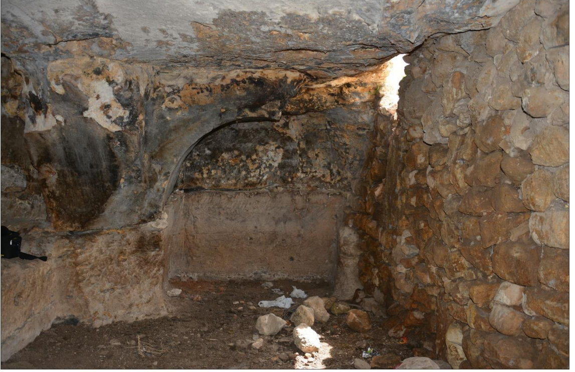
Resim 3.31: Yolveren Köyü Kaya Oyma Mekân ön giriş mekânının güneyindeki mekândan görünüm
