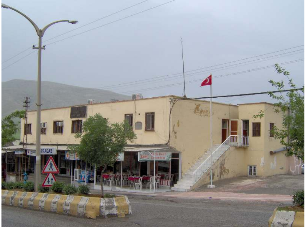
Foto 6: Hasankeyf Kaymakamlık binası. Kaymakamlık daha önce “belediye oteli” olarak 1989 yılında inşa edilmiş 2 katlı bir binada hizmet yürütmektedir.
