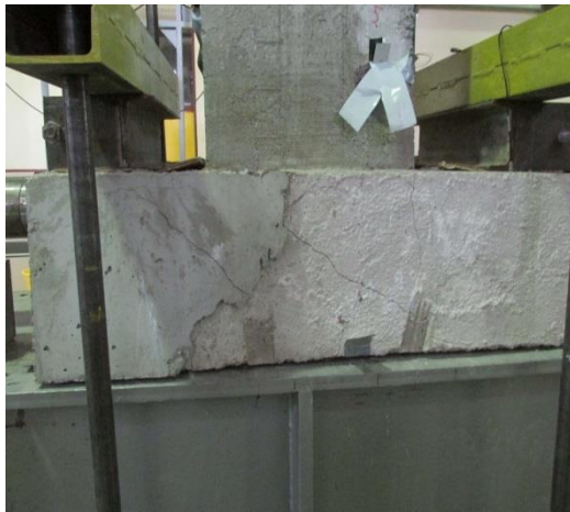
a) Temel pabucunda oluşan çatlaklar
