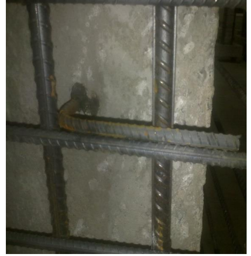
b) Kayma donatısının yerleşimi
