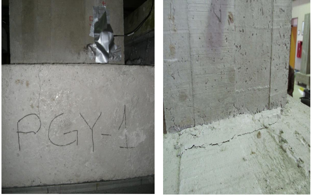
a) Temel pabucunda oluşan çatlaklar
