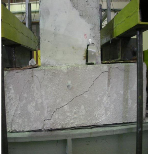
a) Temel pabucunda oluşan çatlaklar
