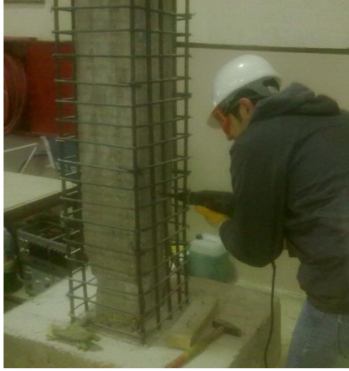
a) Kayma donatısının ekimi için delme işlemi
