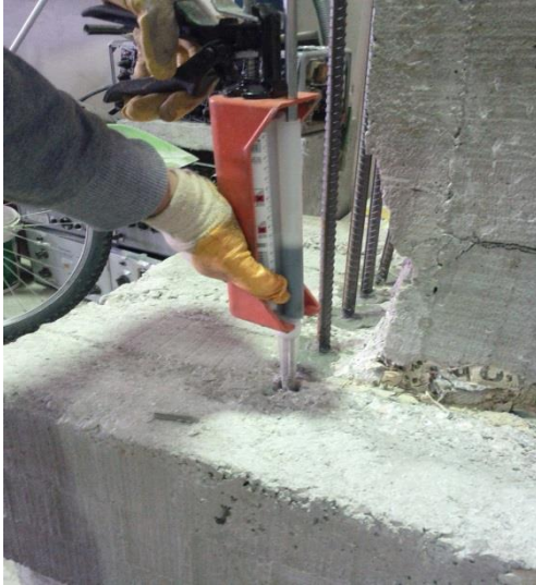
a) Filiz ekimi için epoksi uygulaması
