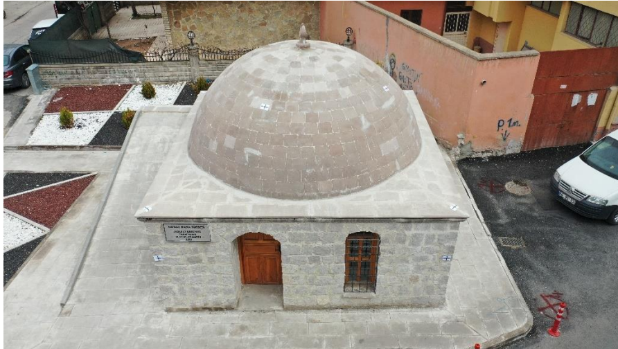
Şekil 5.15. Aksaray Hasas Baba Türbesi İHA görüntüsü-1.
