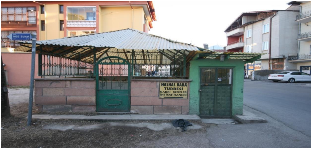
Şekil 5.4. Aksaray Hasas Baba Türbesi restorasyon öncesi görüntüsü (Erdal, 2018).
