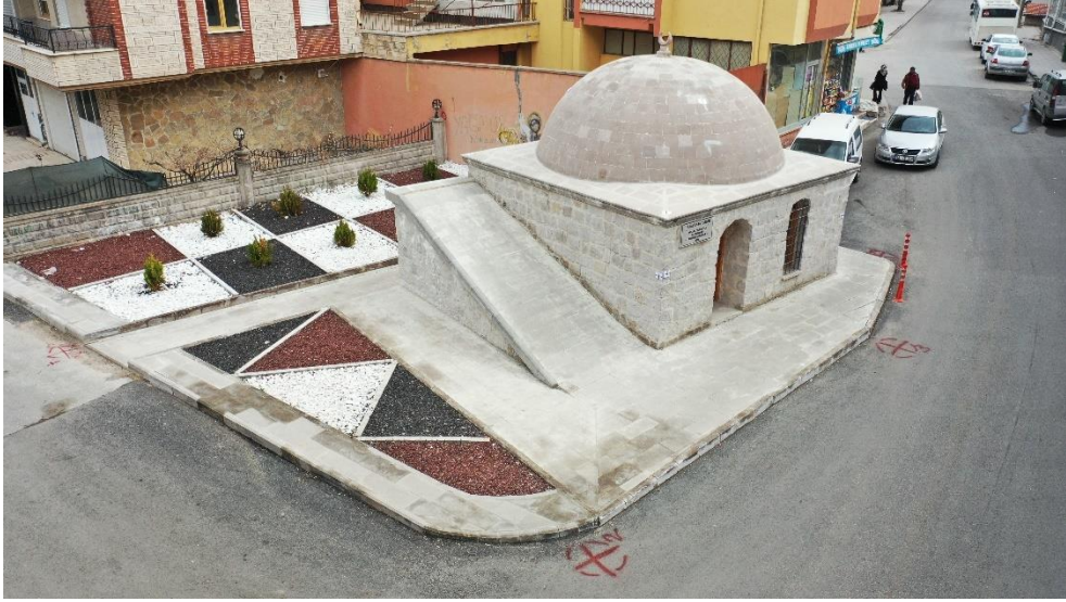
Şekil 5.16. Aksaray Hasas Baba Türbesi İHA görüntüsü-2.
