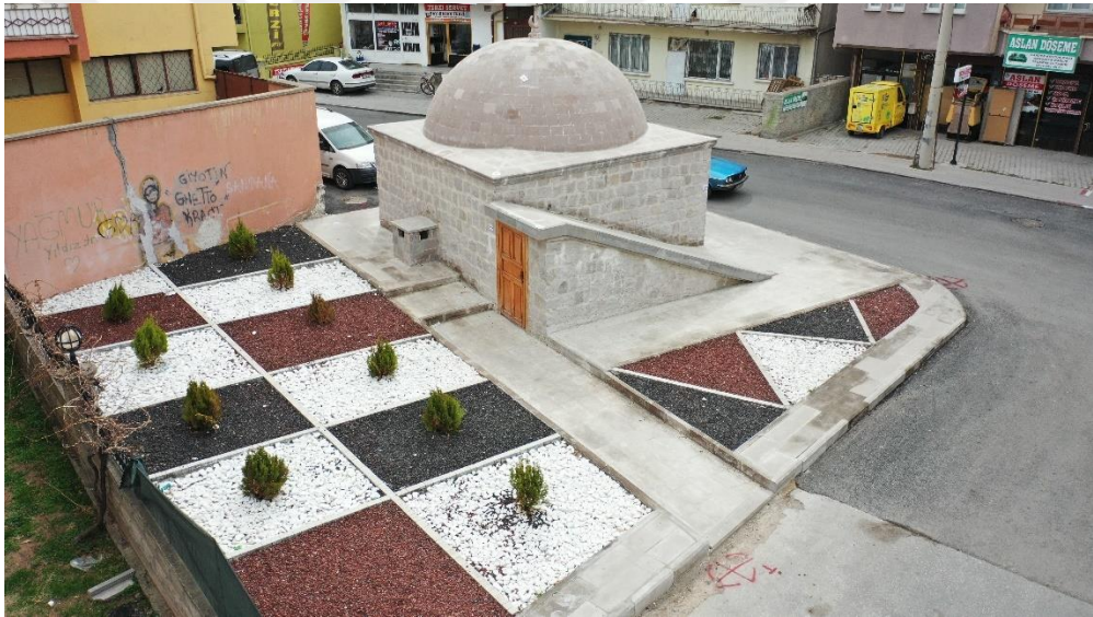
Şekil 5.17. Aksaray Hasas Baba Türbesi İHA görüntüsü-3.
