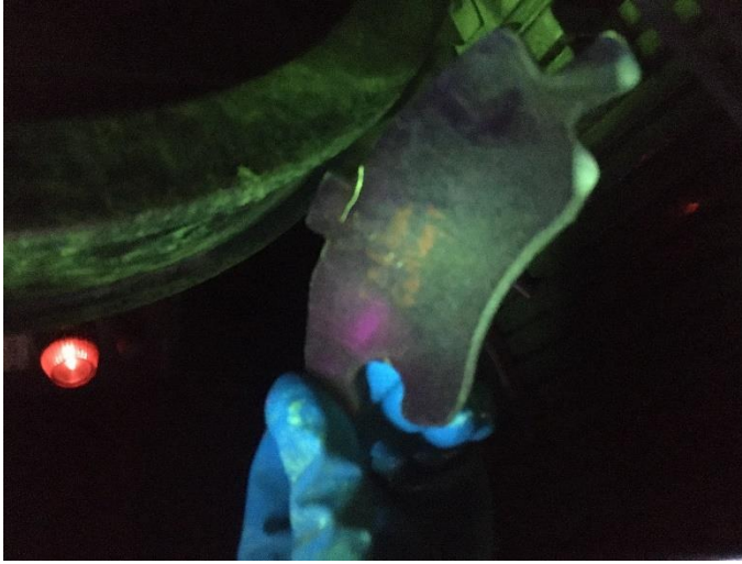
Şekil 78. NDT Aşamasında Görülen Çatlak
