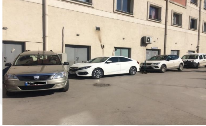
Şekil 2.10. Morg Girişinde Bulunan Tesisat, O 2 , N Kazan Dairesi ve Yakıt Tankı Bölümlerinin Giriş Kapıları
