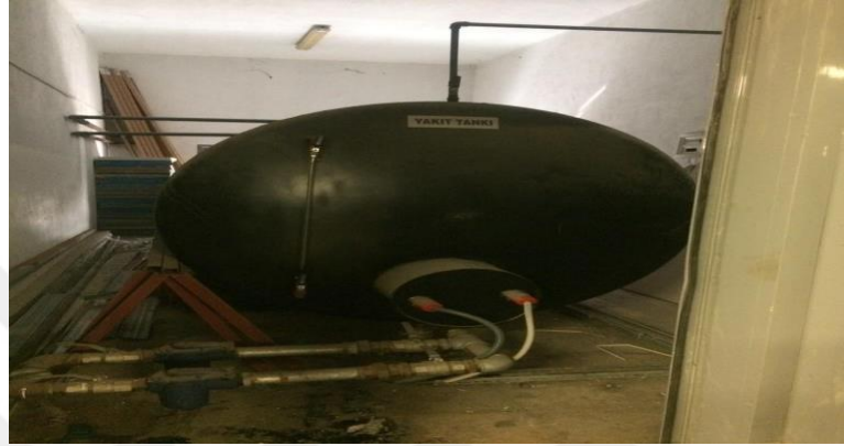
Şekil 2.8. Hastaneye Ait Motorin Yakıt Tankı
