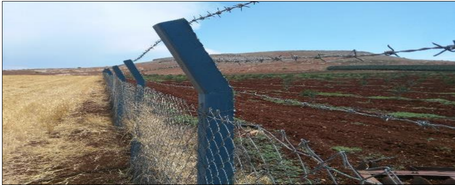
Şekil:7.1 Akpınar mahallesi mevki’i’nde beton direkli tel çit ihata (Çoğal 2017)
