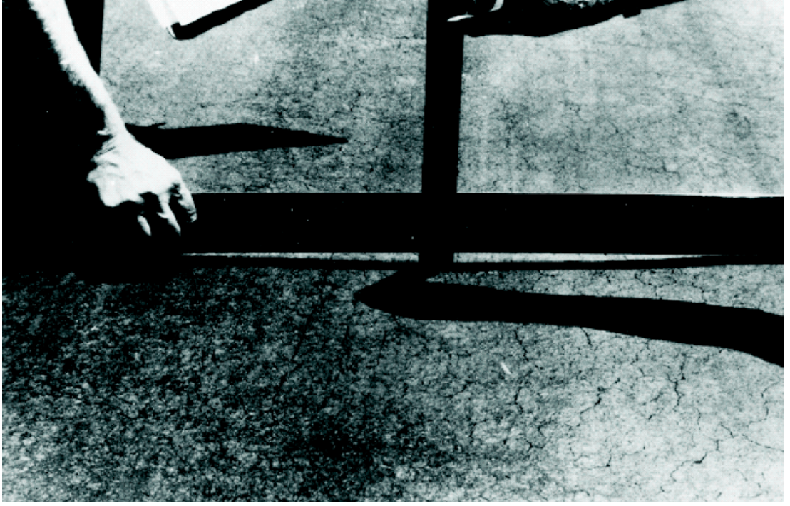
Resim 3.41. Orta hasar seviyesinde tekerlek izi [23]
