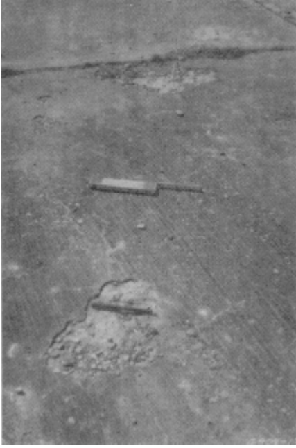
Resim 2.44. Yüksek hasar seviyesinde soyulma (yakın plan) [19]
