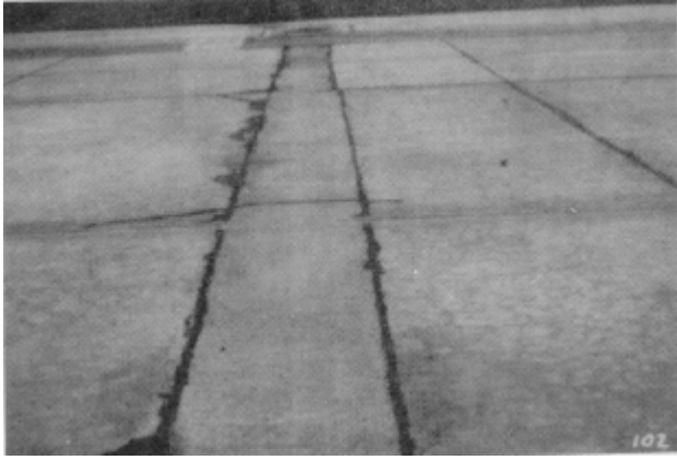
Resim 2.34. Düşük hasar seviyesinde kolaylık yaması [20]
