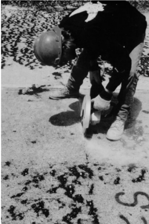
Resim 5.10. Çatlağın beton testeresiyle genişletilmesi ve düzeltilmesi [41]
