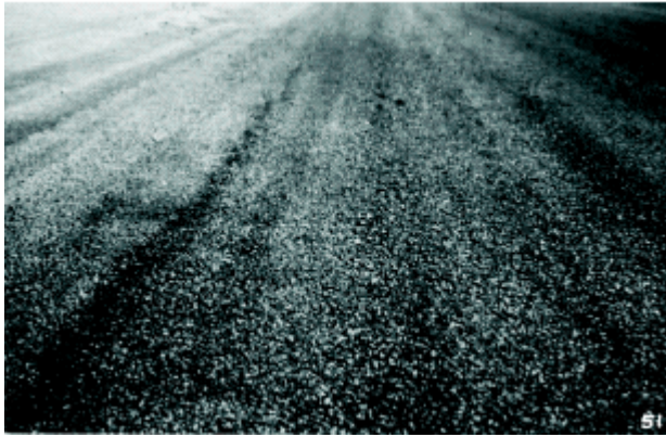
Resim 3.32. Düşük hasar seviyesinde çözülme [23]
