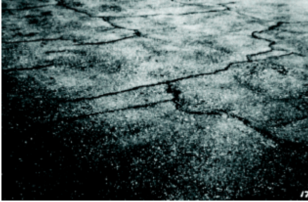
Resim 3.6. Orta hasar seviyesinde blok kırılması [23]
