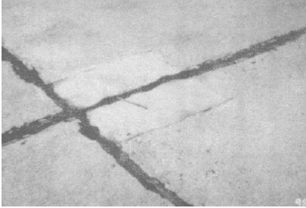
Resim 2.28. Düşük hasar seviyesinde küçük yama [20]
