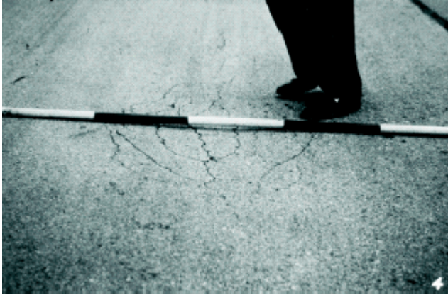
Resim 3.11. Orta hasar seviyesinde çökme [23]
