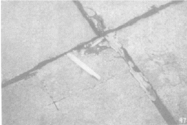
Resim 2.29. Orta hasar seviyesinde küçük yama [20]
