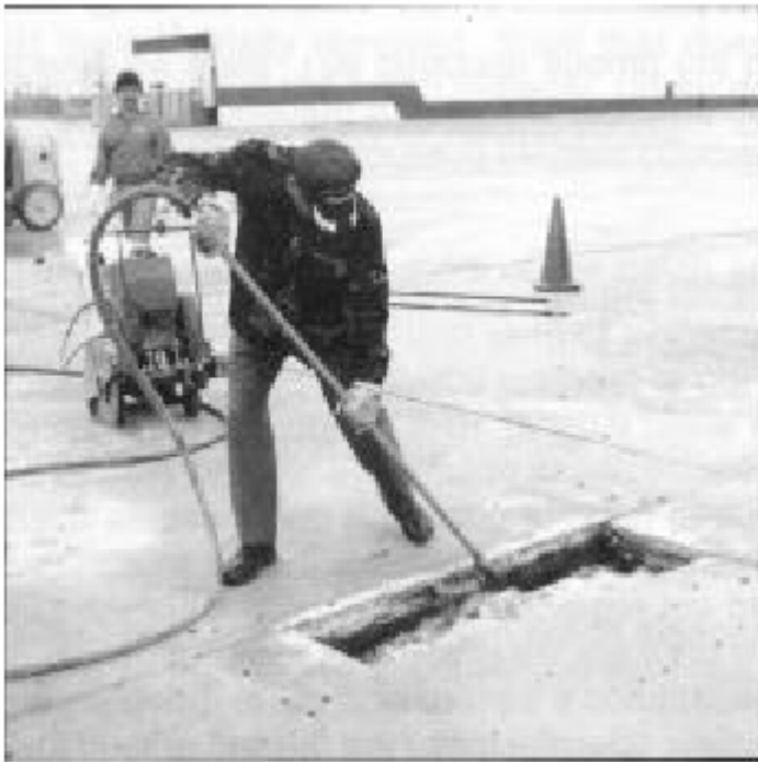
Resim 5.4. Yama içinin kompresörle temizlenmesi [24]
