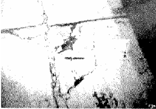
Resim 2.63. Yüksek hasar seviyesinde köşe kopması [20]
