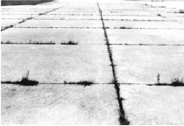
Resim 2.26. Yüksek seviyede derz dolgu hasarı (ciddi boyutta bitki büyümesi) [19]
