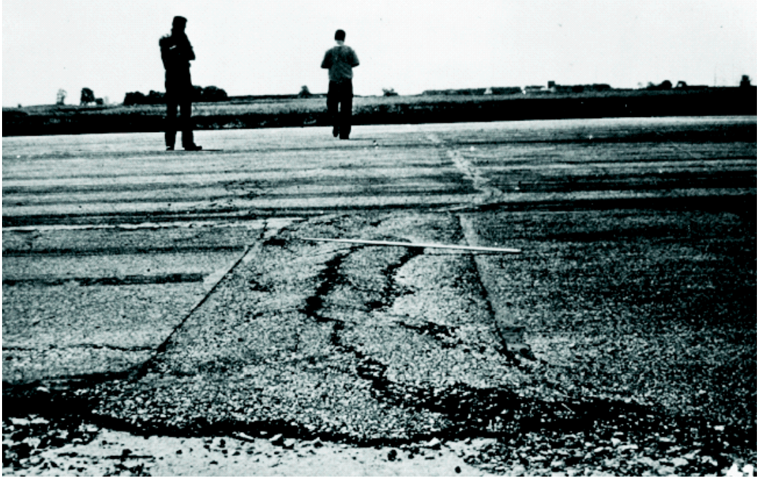
Resim 3.47. Yüksek hasar seviyesinde kabarma [23]
