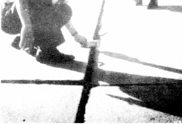
Resim 2.48. Yüksek hasar seviyeli oturma [19]
