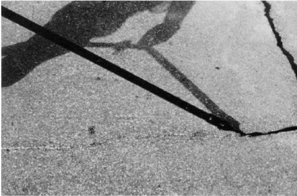
Resim 6.6. Çatlakların doldurulması [43]
