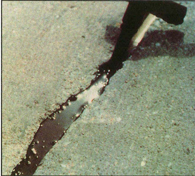
Resim 5.12. Çatlağın derz dolgusu ile doldurulması [32]
