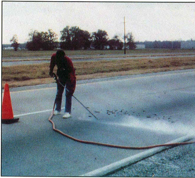
Resim 5.7. Derz veya çatlakların hava kompresörüyle temizlenmesi [32]
