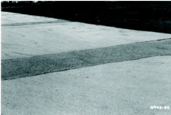
Resim 3.28. Düşük hasar seviyesinde kolaylık yaması [23]
