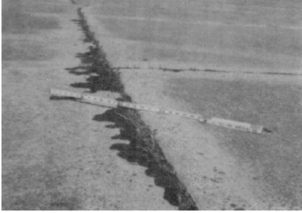
Resim 2.46. Apronda orta hasar seviyeli oturma [19]
