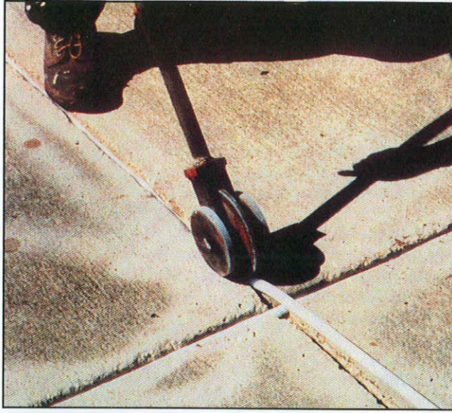
Resim 5.8. Destekleyici çubuğun yerleştirilmesi [32]
