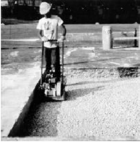
Resim 5.3. Yama tabanının sıkıştırılması [24]
