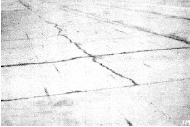
Resim 2.50. Orta hasar seviyeli kesişen çatlaklar [20]
