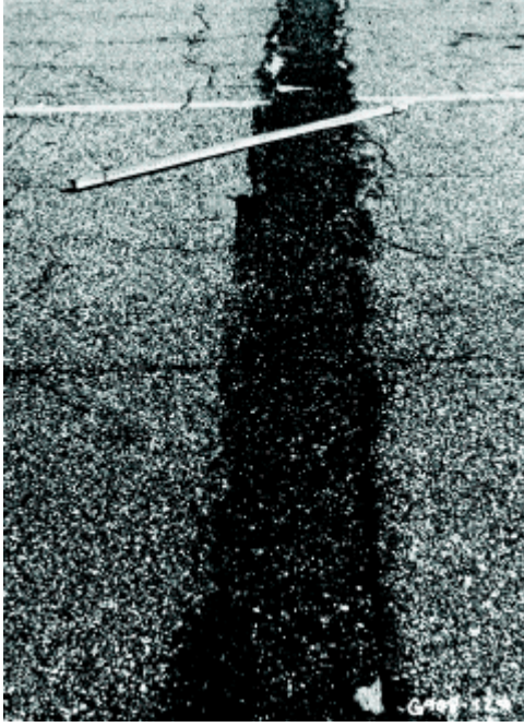
Resim 3.29. Orta hasar seviyesinde kolaylık yaması [23]
