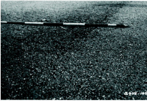
Resim 3.10. Düşük hasar seviyesinde çökme (23)
