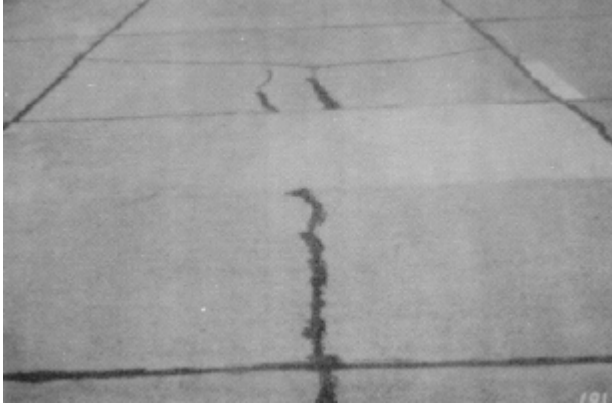
Resim 2.33. Düşük hasar seviyesinde yama [20]
