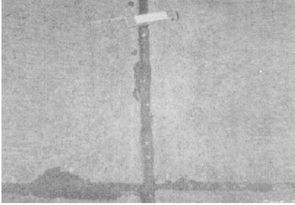
Resim 2.25. Yüksek seviyede derz dolgusu hasarı [20]
