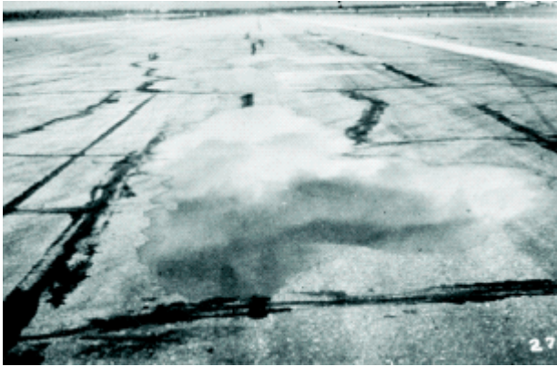
Resim 3.12. Yüksek hasar seviyesinde çökme [23]
