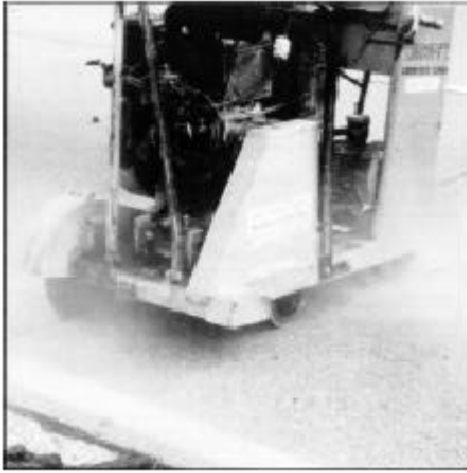
Resim 5.1. Elmas uca sahip beton testeresi ile beton kesimi [24]
