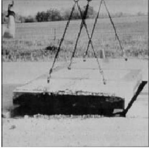
Resim 5.2. Beton kaplamanın komple kaldırılarak sökümü [24]
