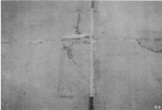
Resim 2.31. Yüksek hasar seviyesinde küçük yama [19]
