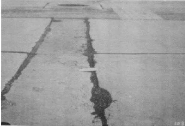
Resim 2.35. Orta hasar seviyesinde kolaylık yaması [20]
