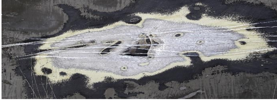
Şekil 46. Hasarlı pal yüzeyine yapıştırılan cam elyaf ipler
