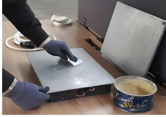
Şekil 62. Kalıp yüzeylerine kalıp ayırıcı uygulaması
