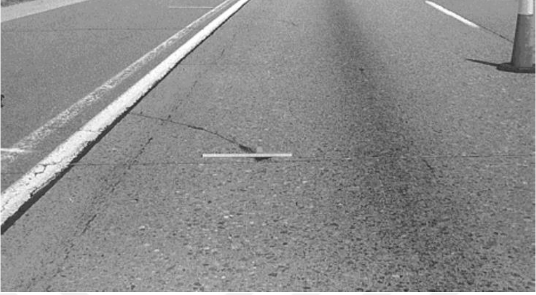
Şekil 20. Köşe çatlağı (Garg vd., 2004)
