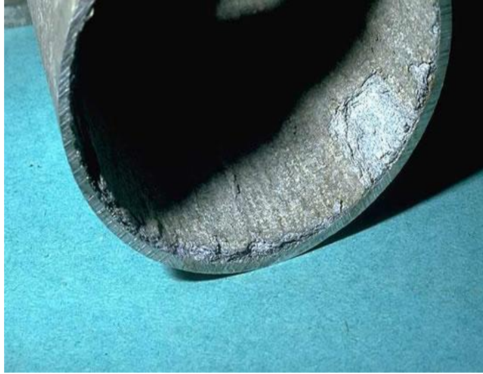
Şekil 1.9 : Taneler arası korozyon örneği [8].
