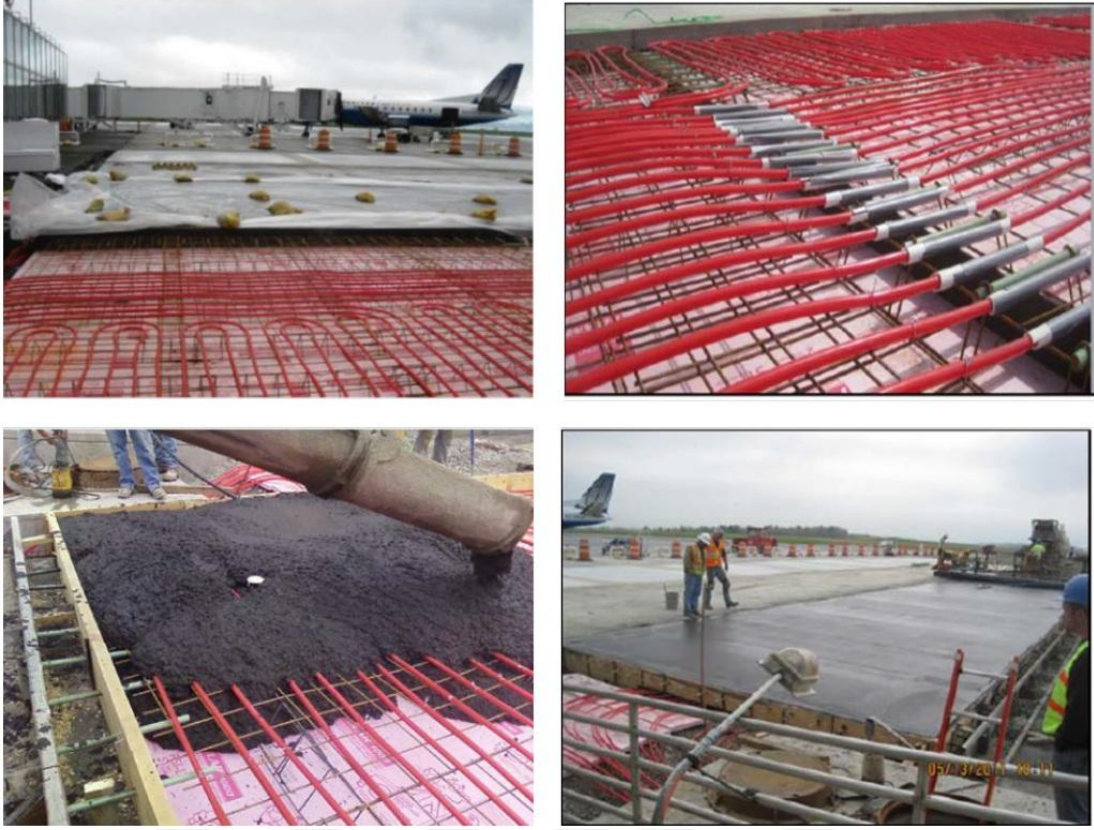
Şekil 2.1. Jeotermal enerji kaynağı kullanarak HIYKS [1].
