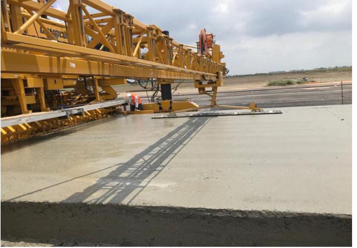
Resim 2. 13. Beton kaplama dökümü sonrası tesviye işlemi (URL-18, 2025)
