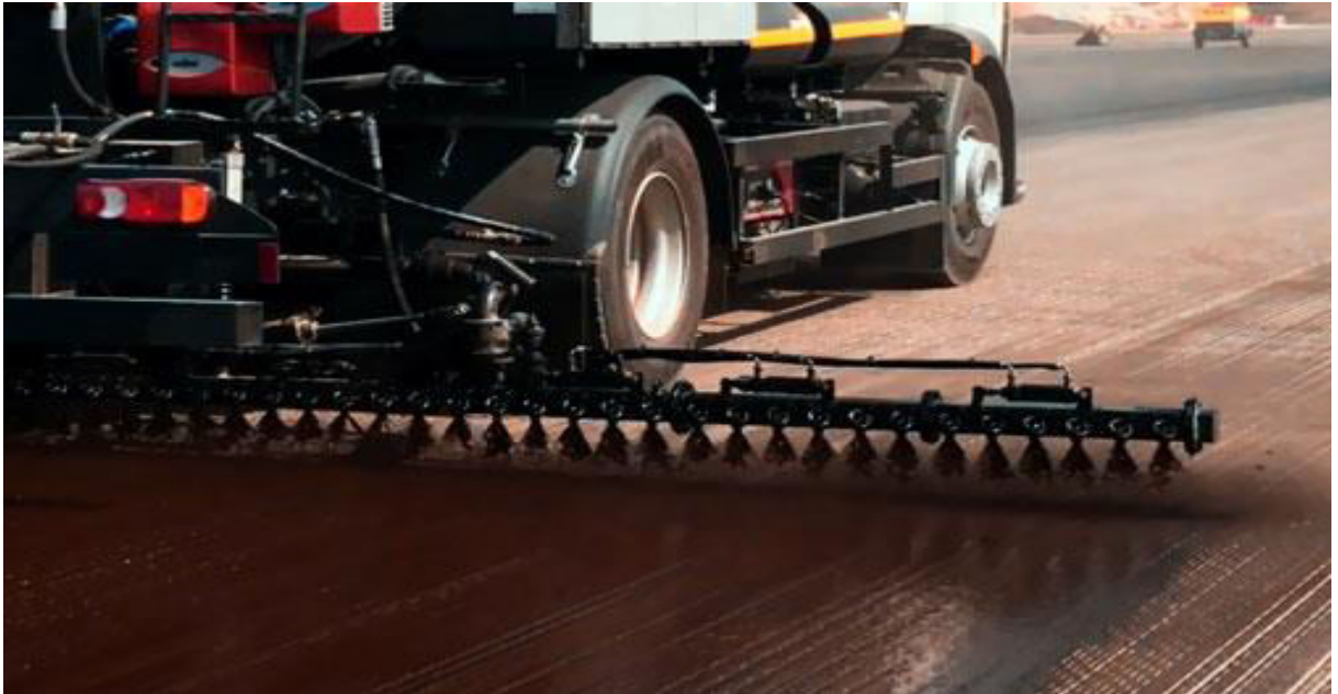
Resim 2. 7. Bitümlü yapıştırıcı tabaka serimi (URL-11, 2025)
