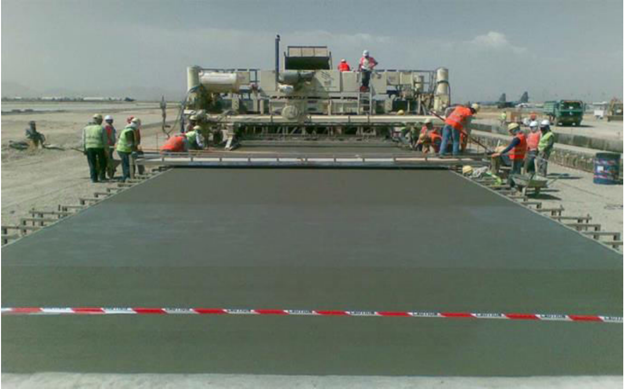
Resim 2. 14. Beton kaplama dökümü tesviye işlemi (URL-19, 2025)
