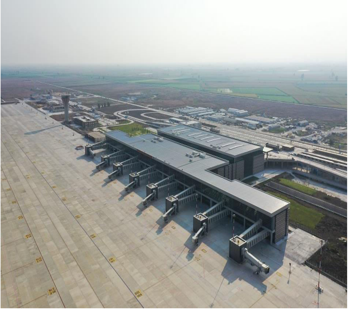
Resim 1. 3. Çukurova havalimanı apron sahası görünümü (URL-2, 2025)
