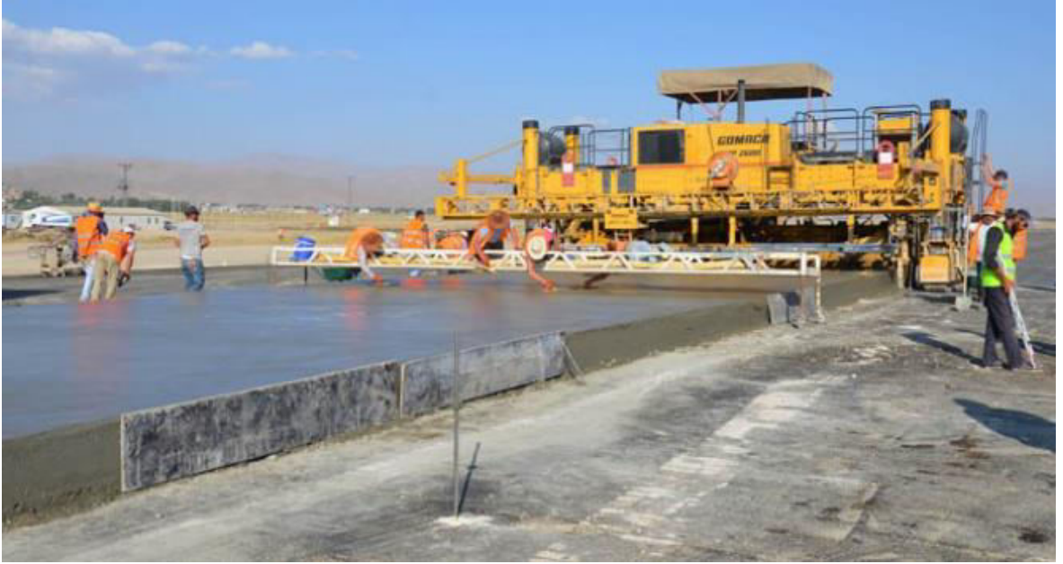
Resim 2. 12. Beton kaplama dökümü (URL-17, 2014)
