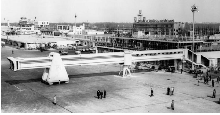
Resim 2.6. Amerika Birleşik Devletleri dışındaki ilk yolcu biniş köprüsü Amsterdam Schiphol'de hizmete geçmiştir [6]
