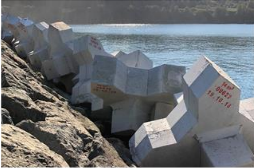
Şekil 4.2. Rize-Artvin Havalimanında kullanılan X bloklar.
