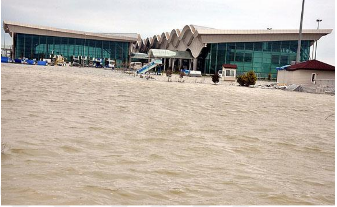
Şekil 3.8. Hatay Havalimanı geçirimsizlik perdesi imalatı öncesi taşkın sırasındaki görünümü (2012).
