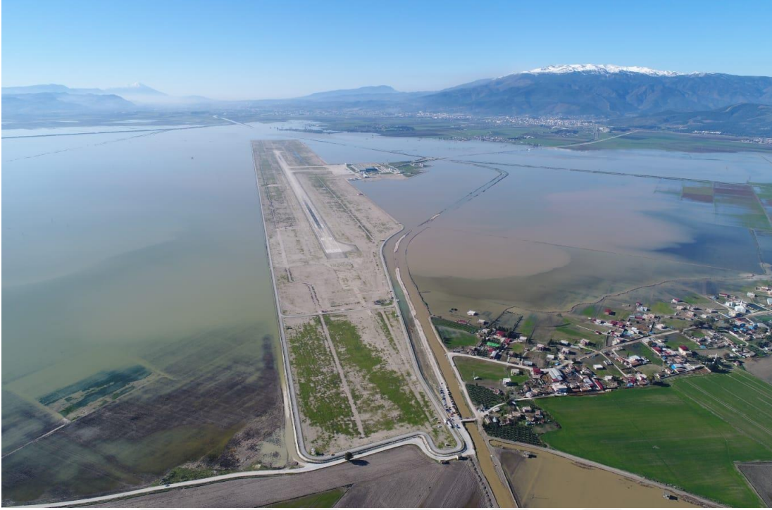
Şekil 3.10. Hatay Havalimanı geçirimsizlik perdesi imalatı sonrası taşkın sırasındaki görünümü (2020).
