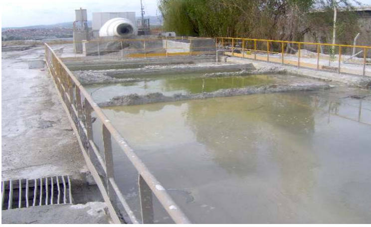
Resim 3.5. Hazır beton santralı çöktme havuzu
