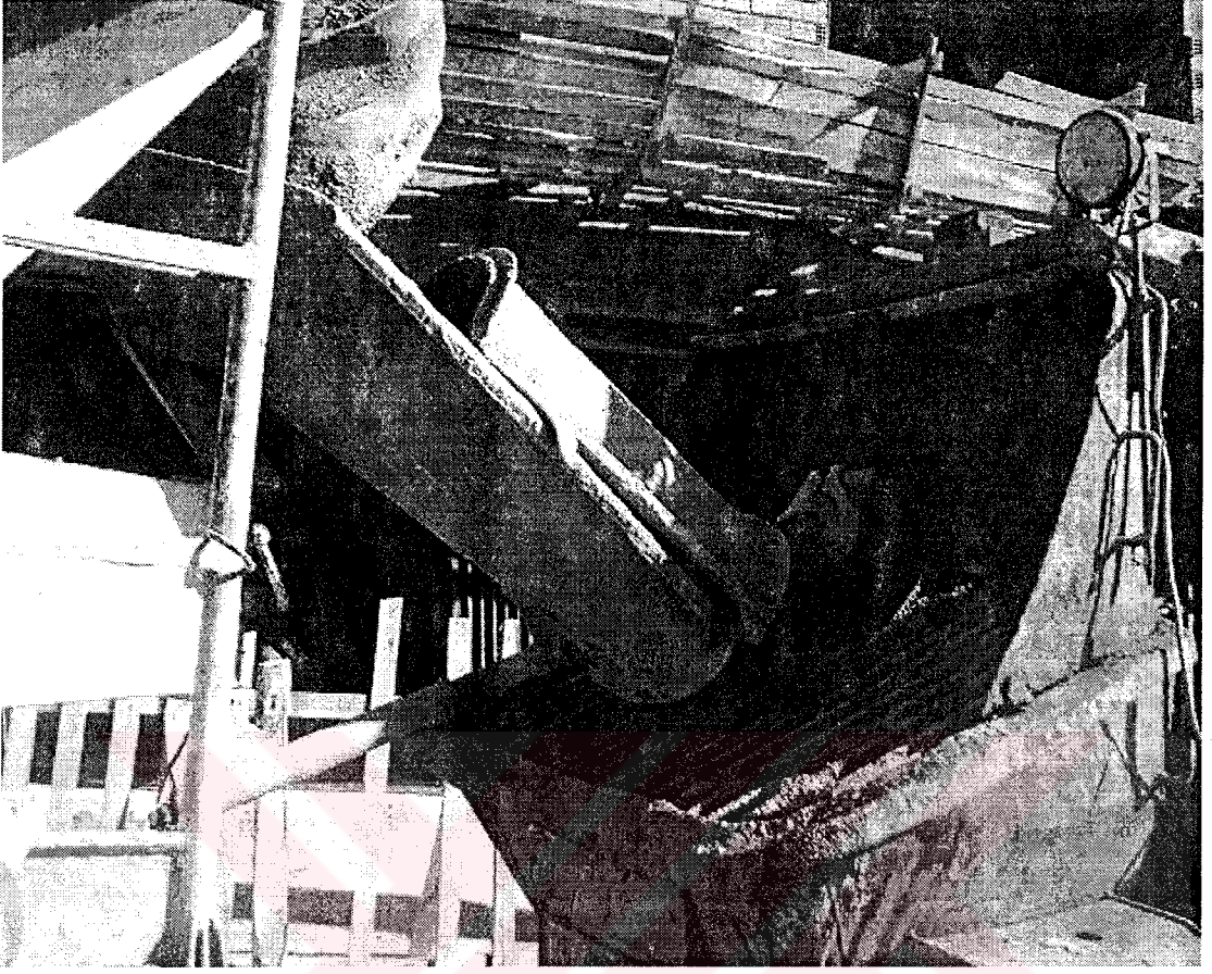
Şekil 5.17: Hazır Betonun Mikserden Pompaya Aktarılması
