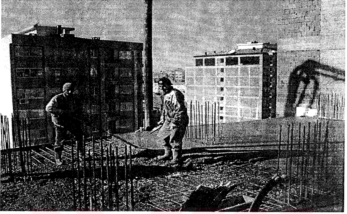
Şekil 5.18: Beton Yerleştirilmesi Esnasında Pompa kullanımı
