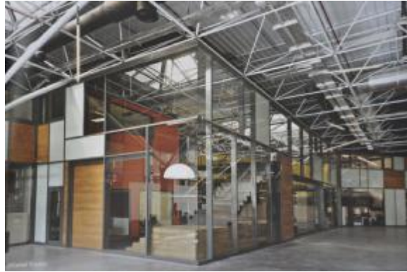
Şekil 52. YEM iç cephe görünüşü
