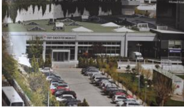
Şekil 51. YEM'in dış cephe görünüşü
