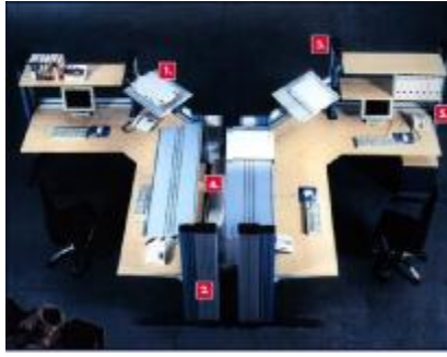
Şekil 136. Çalışma istasyonlarında telefon ve ethernet hattı dağıtım sistemi [modem ünitesi(1), kablo dağıtım kolonları (2, 3) , priz çoğaltıcı ünite(4)]
