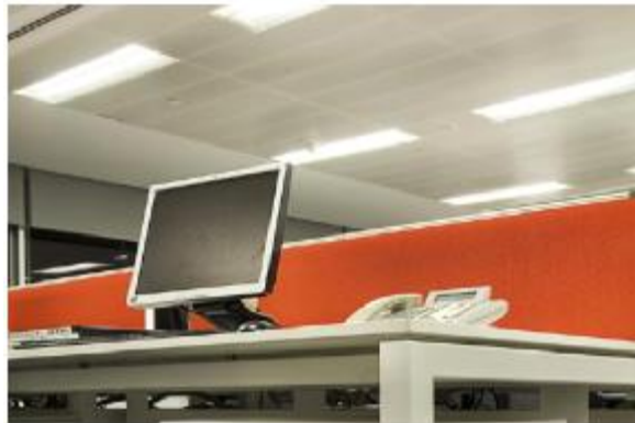
Şekil 127. Çalışma istasyonu masası ön panelinin, des yutucu özellikte melamin malzeme üzerine sünger ve kumaş ile kaplanmış görüntüsü
