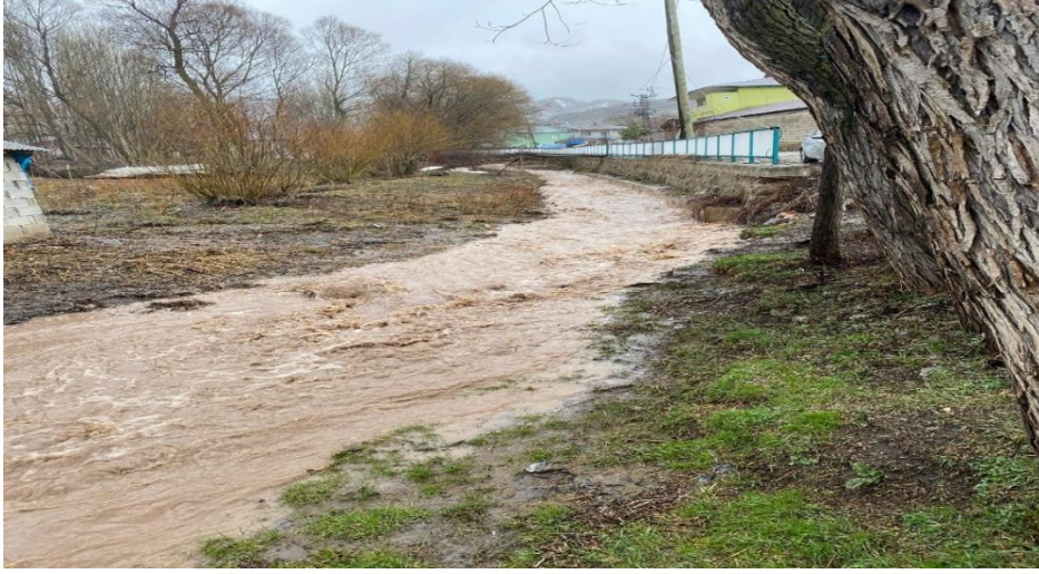
Şekil 27. Bahçecik deresi taşkın riskine açık bir görünüm
