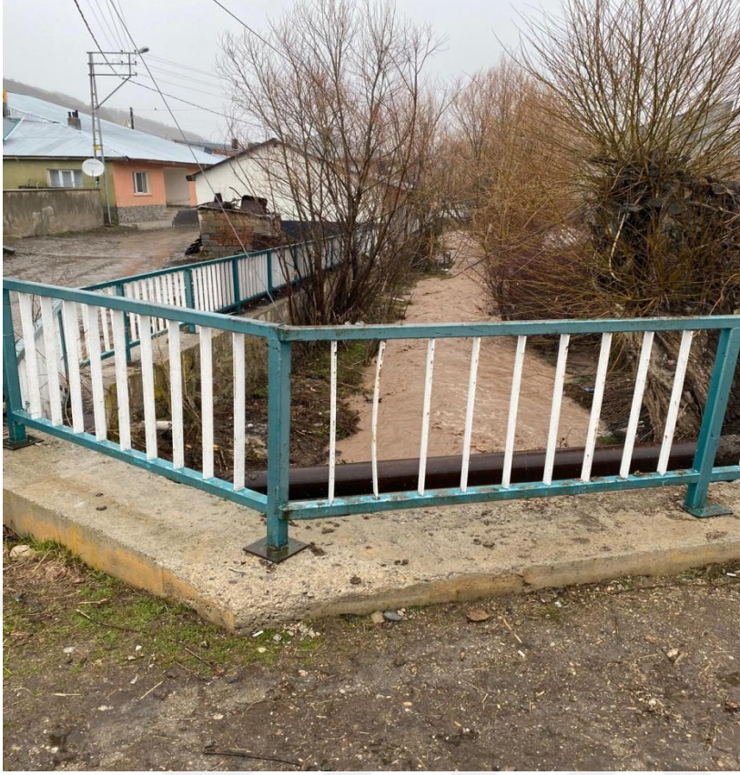
Şekil 78. Bahçecik deresi 760 (3. Menfez) nolu kesit menba görünümü
