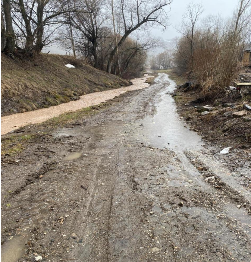
Şekil 81. Bahçecik deresi 1054 nolu kesit menba görünümü
