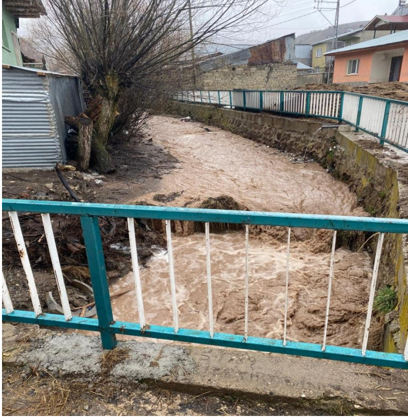
Şekil 108. Bahçecik deresi 906 (2. Menfez) nolu kesit menba görünümü
