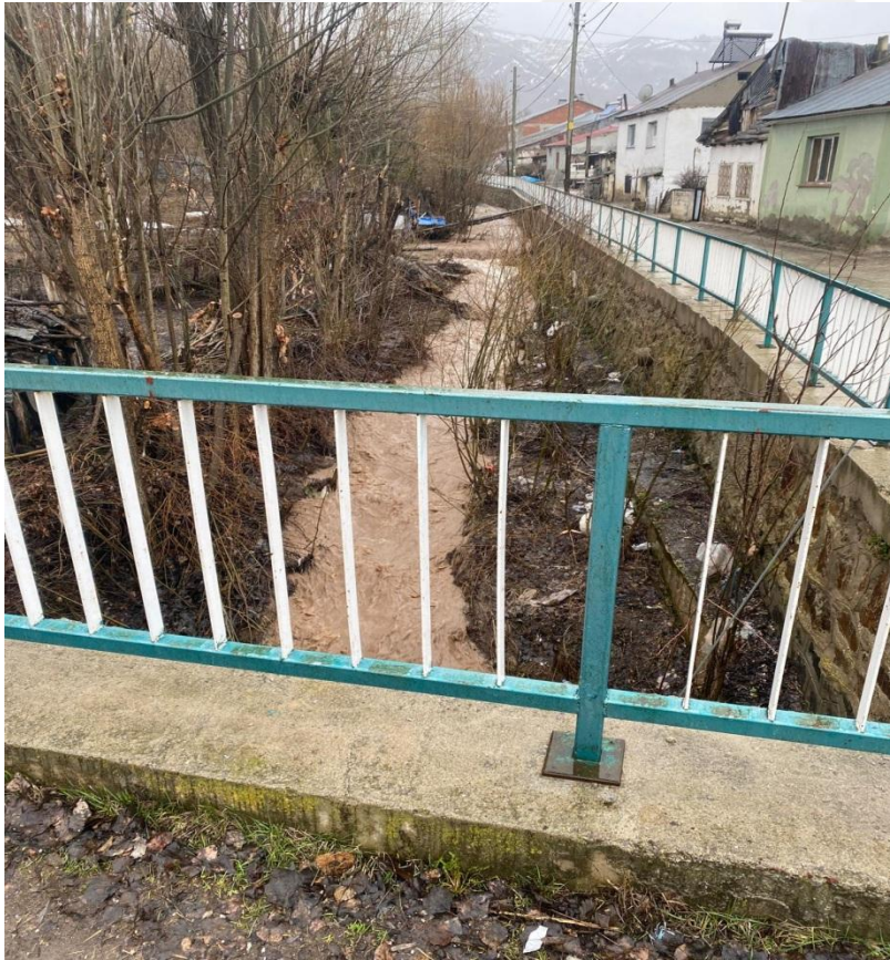
Şekil 101. Bahçecik deresi 957 (1. Menfez) nolu kesit menba görünümü
