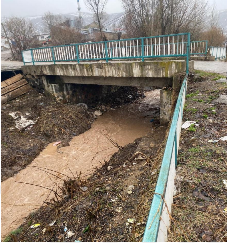
Şekil 92. Bahçecik deresi 906 (2. Menfez) nolu kesit menba görünümü
