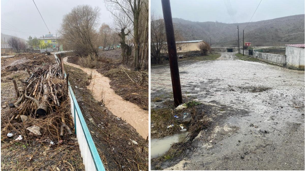
Şekil 26. Yeni Yol Köyü Bahçecik Deresi Mevcut Bir Görünümü
