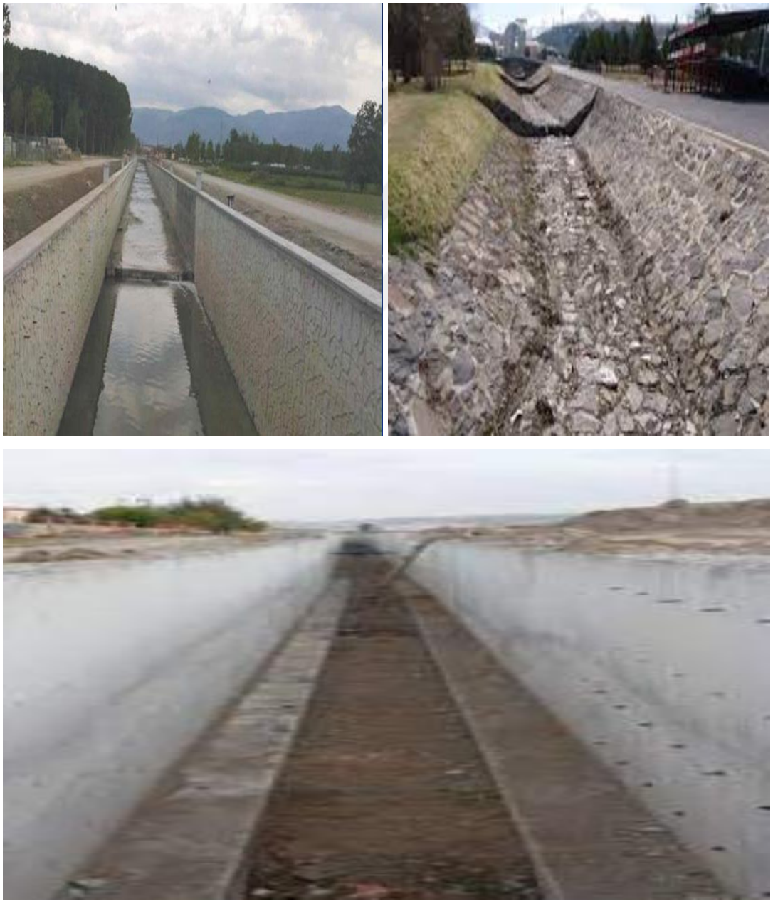
Şekil 11. Taşkın Koruma Kanalları Örnekleri (DSİ)
