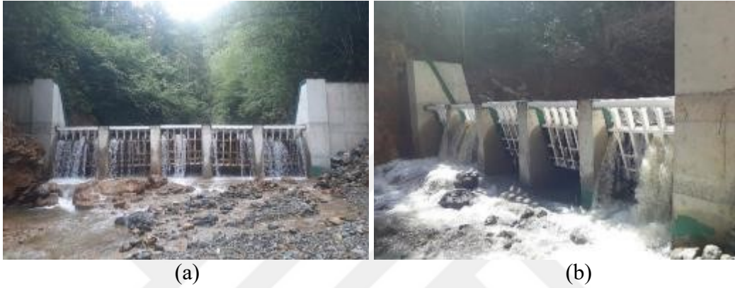
Şekil 6. Giresun Dereli Akkaya Köyü ızgaralı geçirgen tersip bendi
