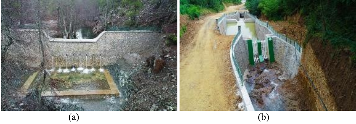
Şekil 4. (a) Muğla Ula Turgut Köyü tersip bendi, (b) Trabzon Akçaabat Kof Deresi geçirgen tersip bendi (URL-5, 2023; URL-6, 2023)
