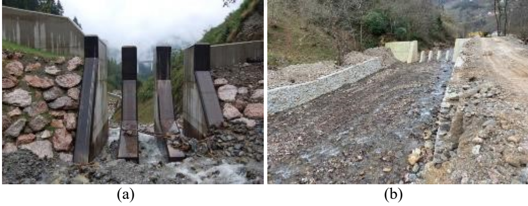
Şekil 5. (a) Ayaklı geçirgen tersip bendi, (b) Giresun Dereli Akkaya Köyü ayaklı geçirgen tersip bendi (URL-7, 2022)
