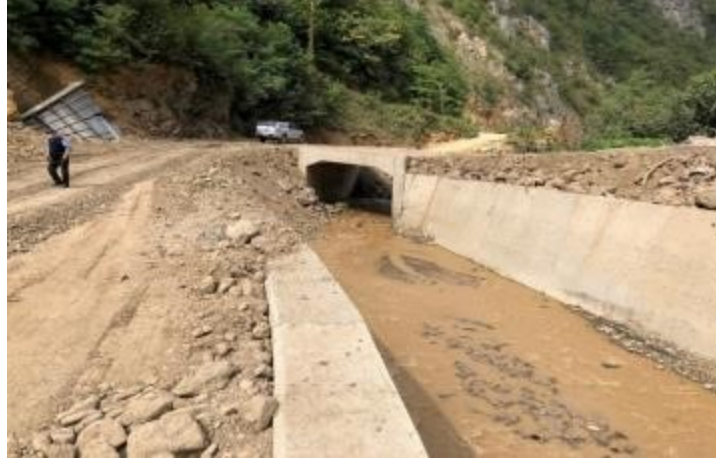
Şekil 14. Kızılot mevkiinde DSİ tarafından yapılan Kuşluhan Mahallesi'ne geçişi sağlayan menfez imalatı
