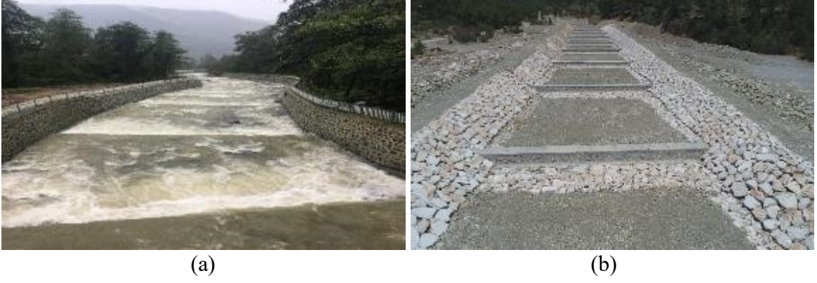
Şekil 3. (a) Artvin Arhavi Lome Deresi taşkın kontrol duvarları ve brit imalatları, (b) Muğla Köyceğiz Çayhisar Deresi taban kuşağı (URL-3, 2023; URL-4, 2023)
