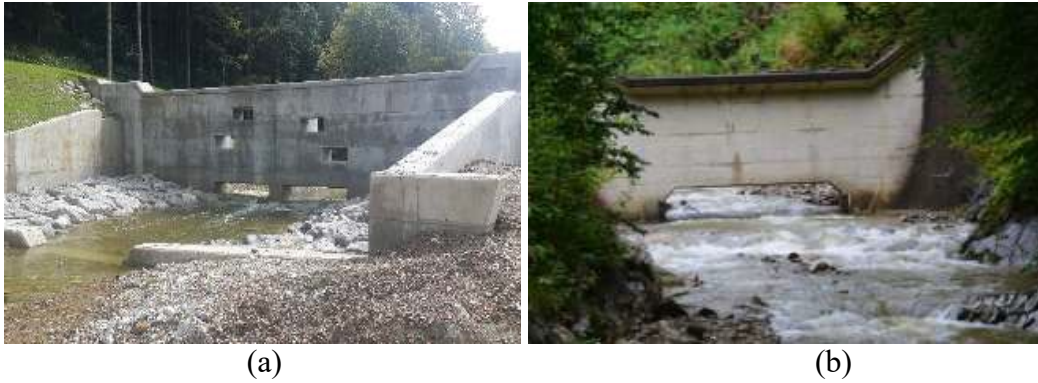
Şekil 7. (a) Dip açıklıklı geçirgen bent tipi, (b) Dip açıklıklı süzücü bent tipi (Akçalı, 2018; Çelik vd., 2017)
