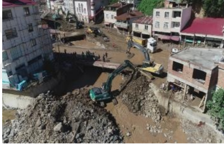
Şekil 15. Taşkından sonraki gün Akkaya Deresi ile Aksu Deresi'nin birleştiği yerde yapılan rüsubat temizliği çalışmaları
