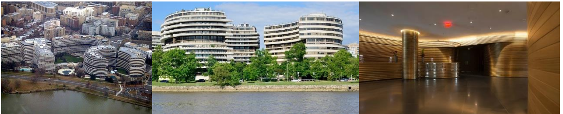
Şekil 3. (a) Watergate Kompleks havadan görüntüsü (Wikipedia, 2006) (b) Watergate Kompleksi cephe görüntüsü (c) Watergate Kompleks iç mekân görüntüsü
