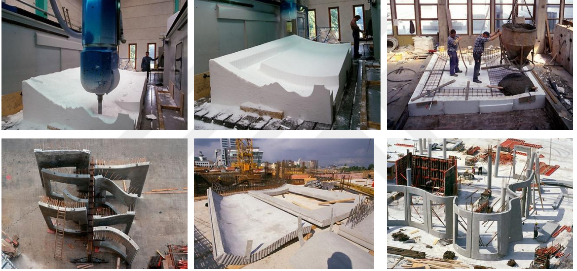
Şekil 23. Gehry'nin Düsseldorf'taki Zollhof Kuleleri için betonarme panellerin dökümüne yönelik strafor kalıpların frezelenmesi (URL-15)
