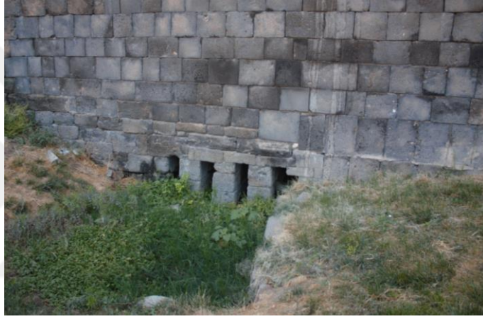
Şekil 3. 30 Sur duvarlarında organize edilen atık su çıkışları (Aydoğdu arşivi,2021)
