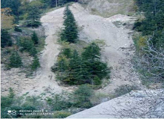
Şekil 18. Orman yolu inşaatının sebep olduğu heyelan alanı
