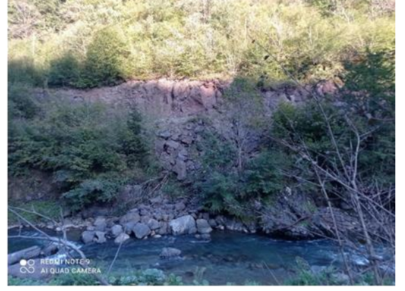
Şekil 18. Orman yolu inşaatının sebep olduğu heyelan alanı
