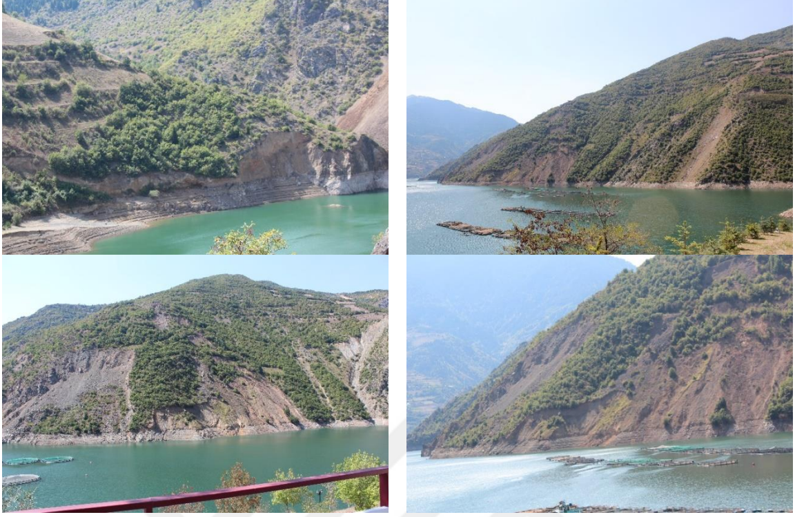
Şekil 17. Kürtün barajı göl alanındaki yamaç duraysızlıklarına örnekler
