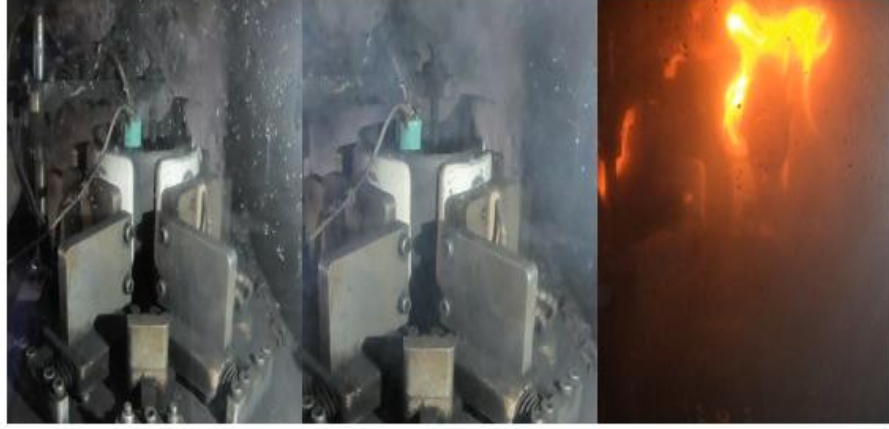
Şekil 4.8. NOVEC 1230 müdahalesi, gaz salınımı ve yangın.
