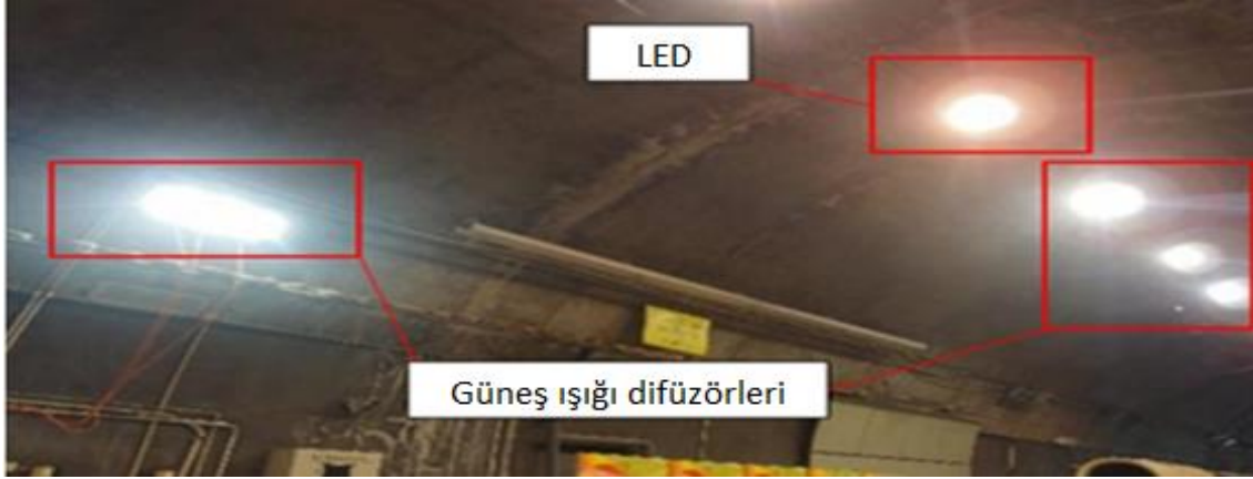
Resim 2.7 Tünel aydınlatmalarında güneş ışığı yoğunlaştırıcı sistemlerinin kullanım örneği (Shi vd. 2023).
