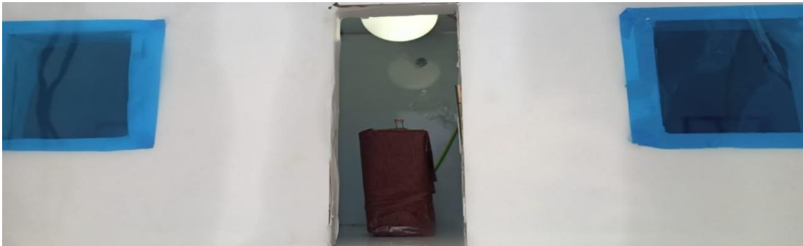
Resim 3.14’de günışığı yoğunlaştırıcılı fiber optik aydınlatma sistemi aracılığı ile yoğunlaştırılarak iç ortama aktarılan ışığın aydınlatma durumu gösterilmiştir. Difüzör, fiber optik kablo aracılığı ile ortama dik bir şekilde taşınan günışığını homojen bir şekilde ortama yayılabilmesi amacıyla kullanılmıştır.
