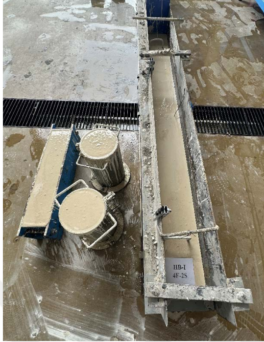
(c) Kiriş numune beton dökümü
