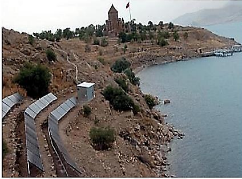
Şekil 2.1: Akdamar adası güneş enerjisi uygulaması (Rüstemli ve Dinçer, 2011).
