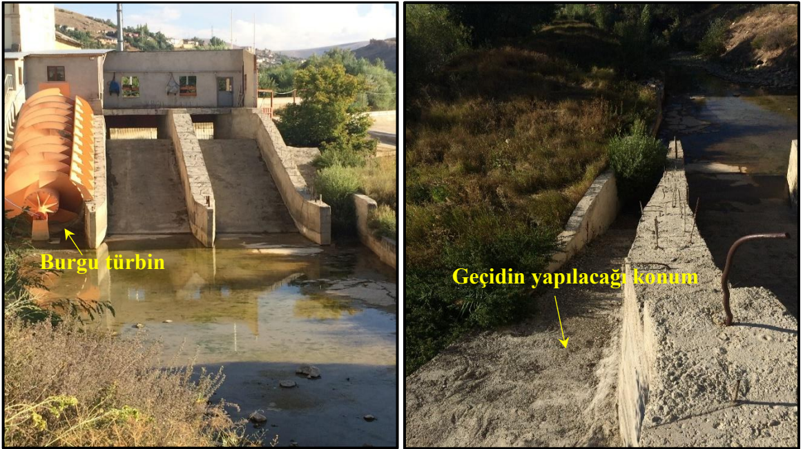
Şekil 3.47. Burgu türbin ve balık geçidinin yapılacağı konum
