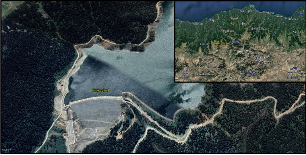
Şekil 3.29. Gökçebel Barajı'nın uydu görüntüsü
