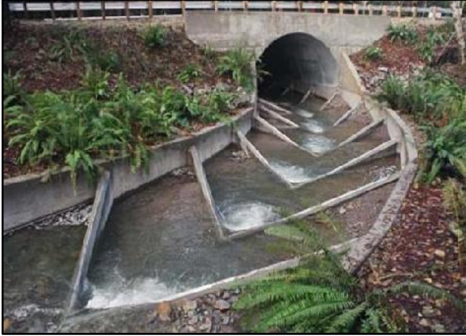
Şekil 1.25. Menfez tipi balık geçidi (Üçüncü ve Altındağ, 2012).
