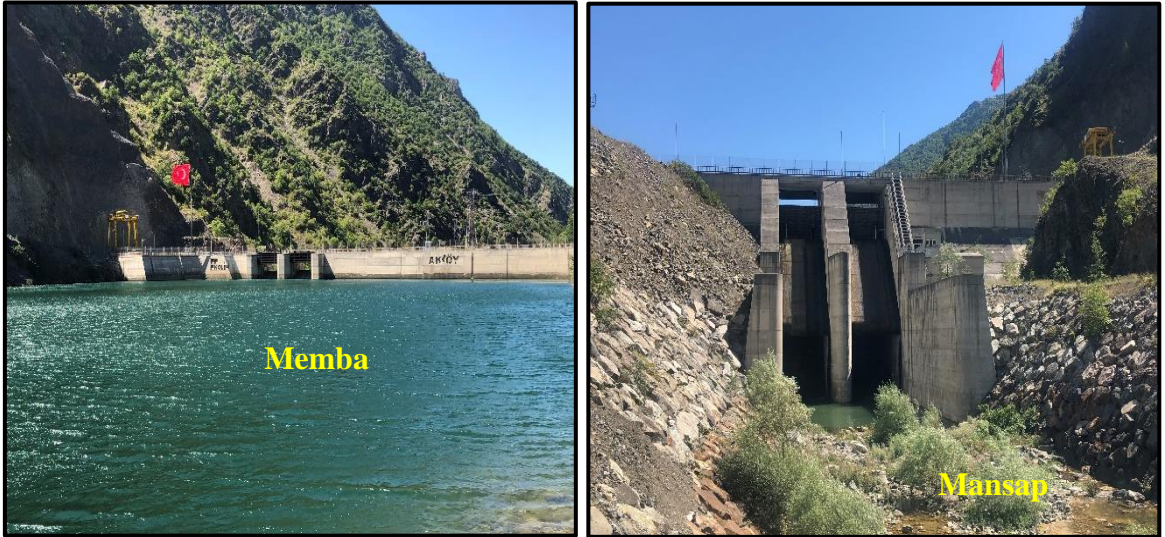
Şekil 3.27. Akköy 1 Barajı'nın memba ve mansap kısımları
