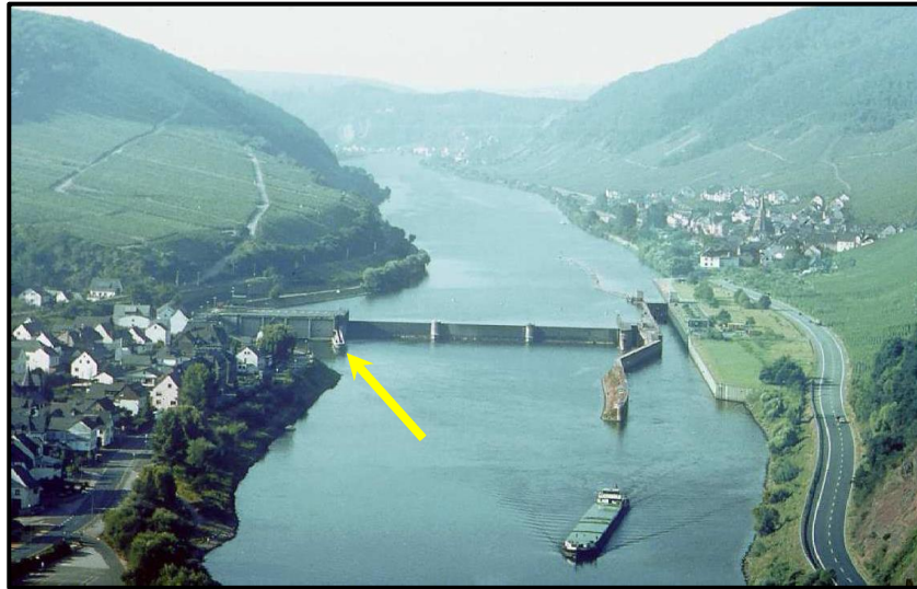
Şekil 1.30. Moselle nehri üzerindeki Neef barajının balık geçidi (ok işaretli) (Tüfek, 2009; Balbay, 2011).
