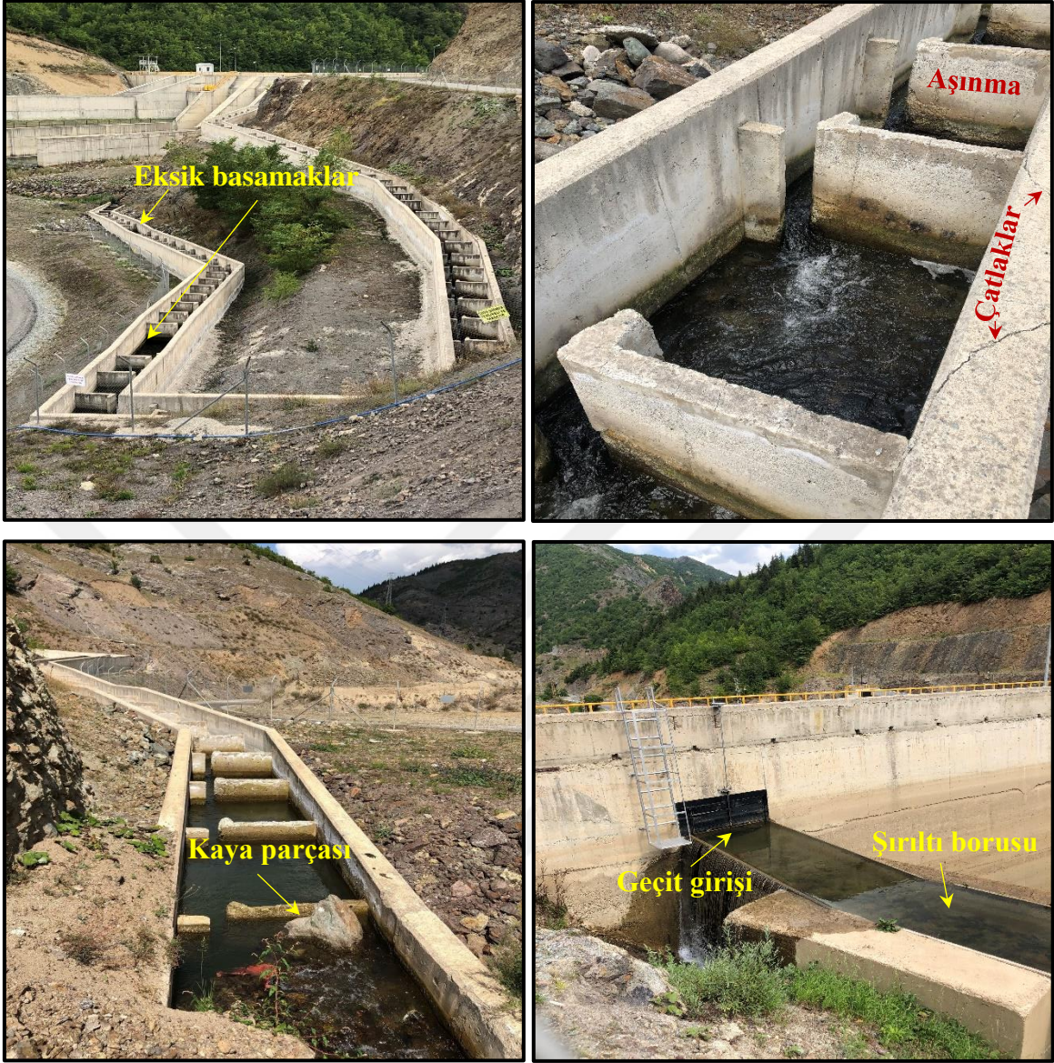
Şekil 3.15. Elmalı regülatöründeki balık geçidinin görünümü ve şırlıtı borusu
