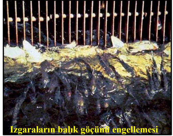
Şekil 1.12. Türbinlerdeki balık geçişleri (URL-8, 2021). Izgaraların balık göçünü engellemesi (Berkün vd., 2008).
