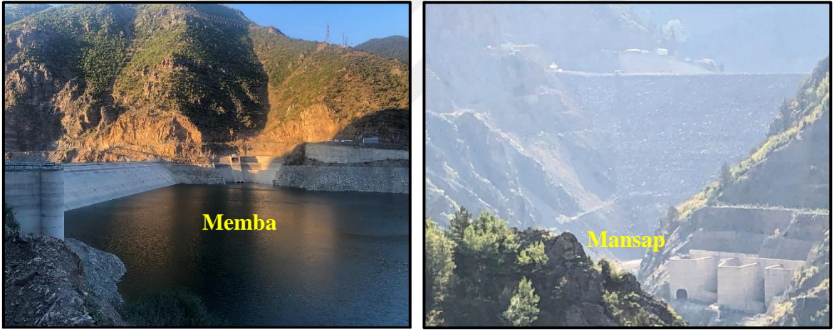
Şekil 3.8. Torul Barajı'nın memba ve mansap kısımları
