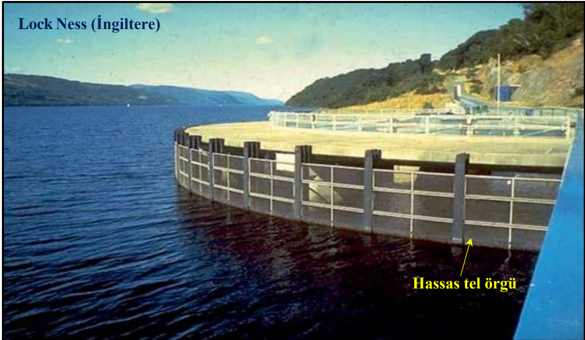
Şekil 1.11. Hidroelektrik güç istasyonunun giriş bölümünün hassas tel örgüyle çevrilmesi (Berkün vd., 2008).
