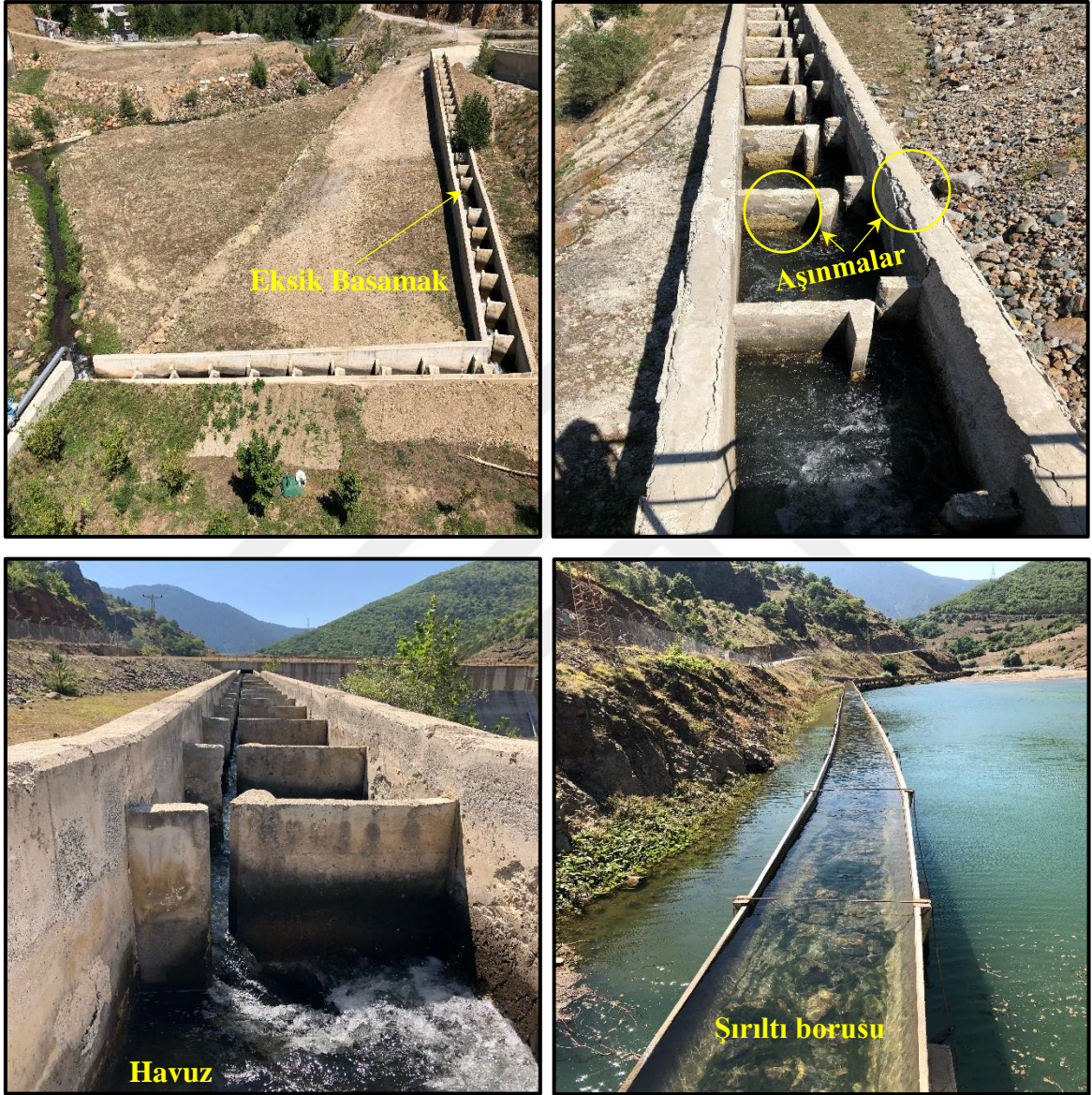
Şekil 3.18. Taşoba regülatöründeki balık geçidi ve şırlıtı borusu
