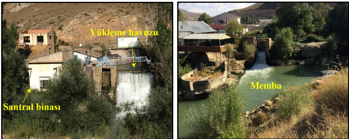
Şekil 3.43. Bayburt HES (Küçük) santral binası, yükleme havuzu ve regülatörü
