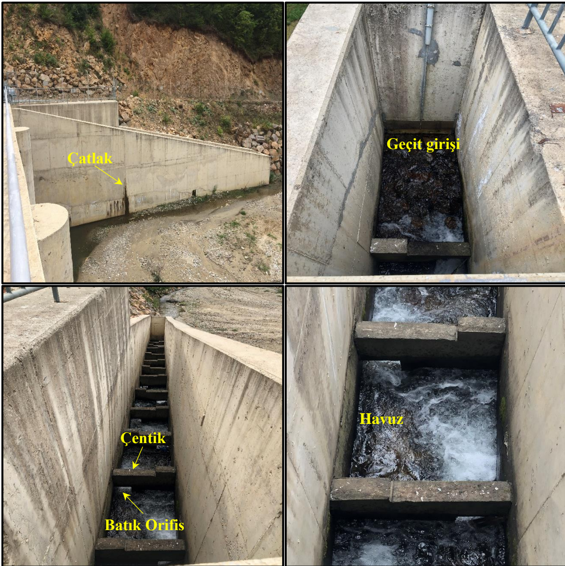
Şekil 3.22. Mor 2 regülatöründeki balık geçidi
