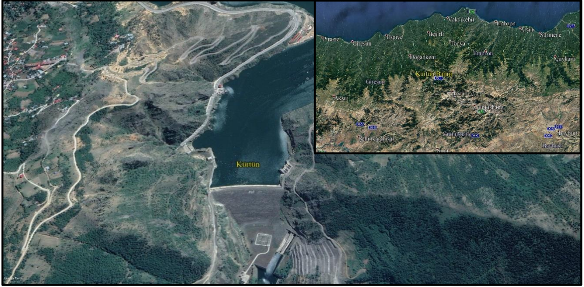
Şekil 3.23. Kürtün Barajı'nın uydu görüntüsü
