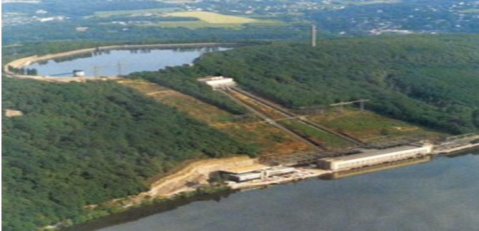
Şekil 1.3. Pompaj Depolamalı HES Örneği (Sertkaya vd., 2015 )
