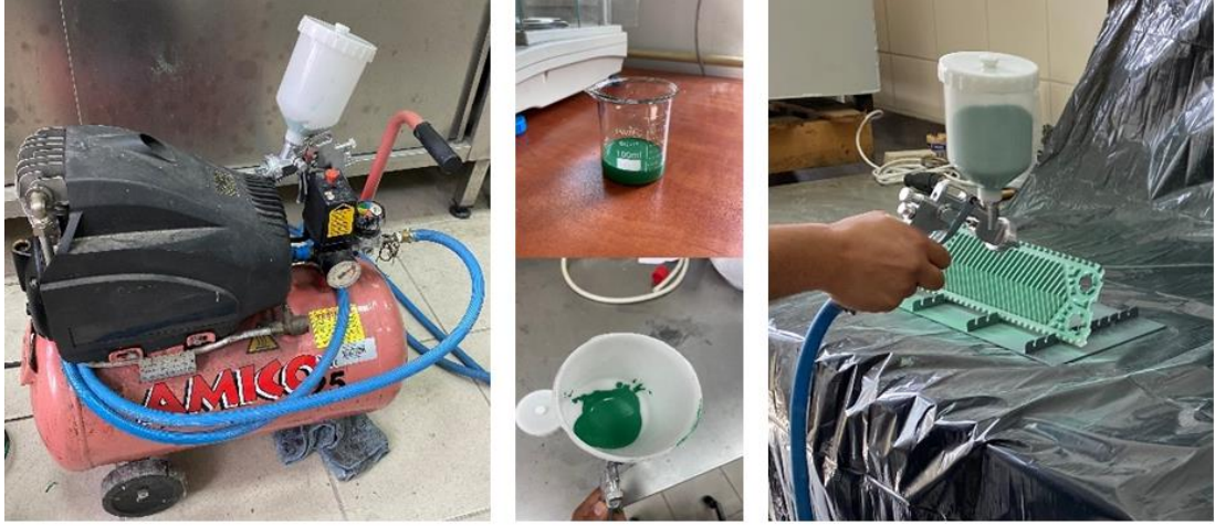
Şekil 5.6. Isı değiştirici plakalarına kaplama işleminin uygulaması
