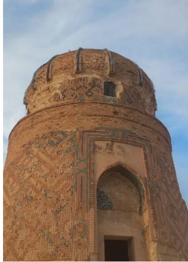
Şekil 1.1. Yığma yapı örneği
