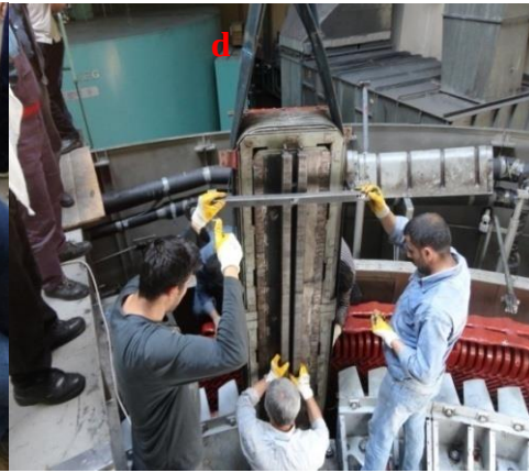
Resim 4.3.d. Rotor kutubu ve bakımı
