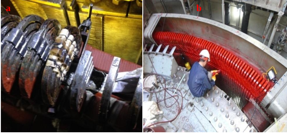
Resim 4.6.a. Sargı kaynak bağlantılarının yapılması Resim 4.6.b. Sargı silikonlama
