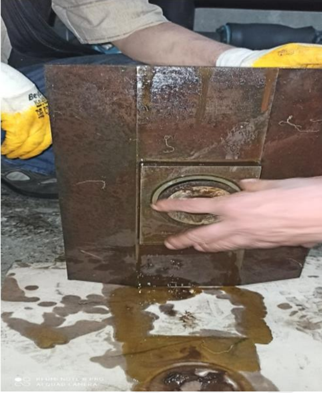
Resim 3.13. Hasar görmüş türbin klavuz yatak önden görünüş
