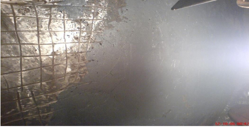
Resim 3.9. Kavitasyon tamiratı çalışması sonrası görünüm
