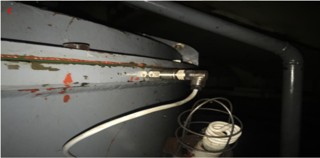
Resim 6.2.c. Generatör klavuz yatak sensörü
