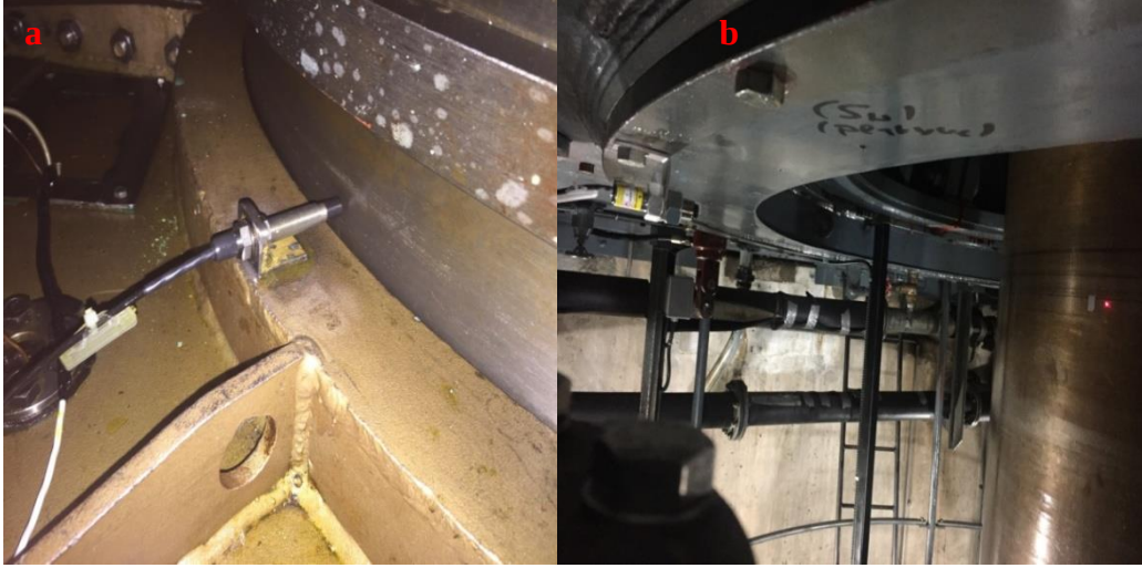
Resim 6.2.a. Türbin kılavuz yatak titreşim sensörü Resim 6.2.b. Şaft (devir hızı) sensörü
