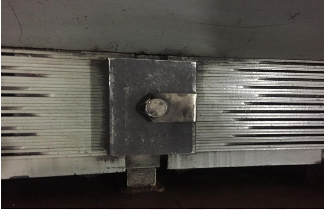
Resim 3.11. Balanssızlık dengeleme ağırlığı
