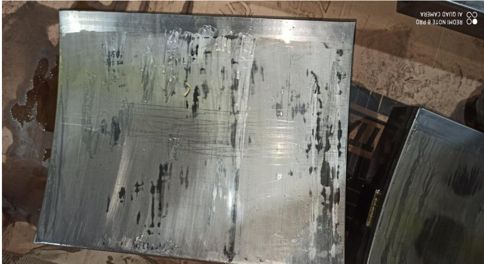
Resim 3.14. Hasar görmüş türbin klavuz yatak yüzeyi
