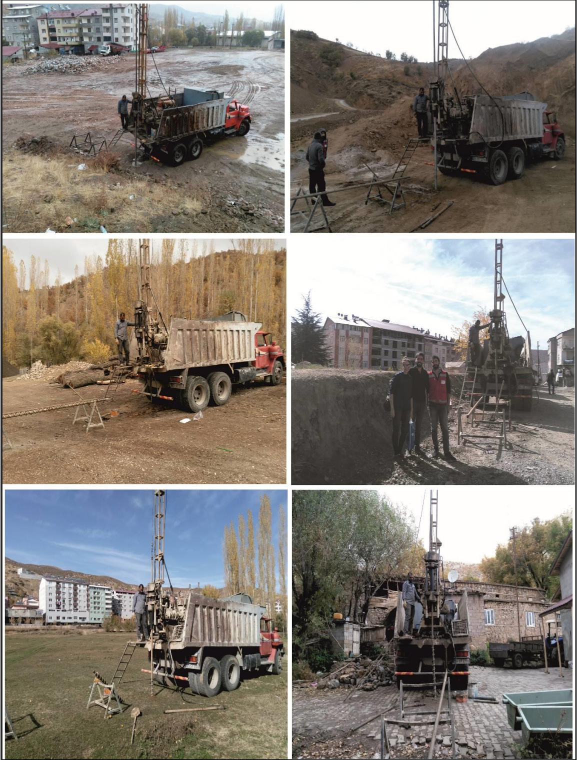
Şekil 3.8. Çalışma alanında yapılan sondajlardan görünüm
