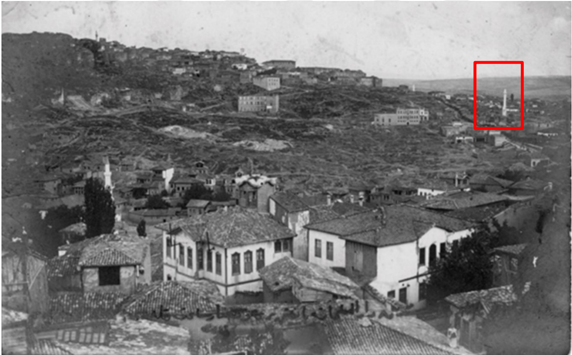
Şekil 66. Hacı Bayram Camisinin bulunduğu tepeden kale yönüne bakış (Sağ tarafta yer alan minare Yeğen Bey Cami'ne ait olduğu düşünülmektedir) (Tamur, 2010)
