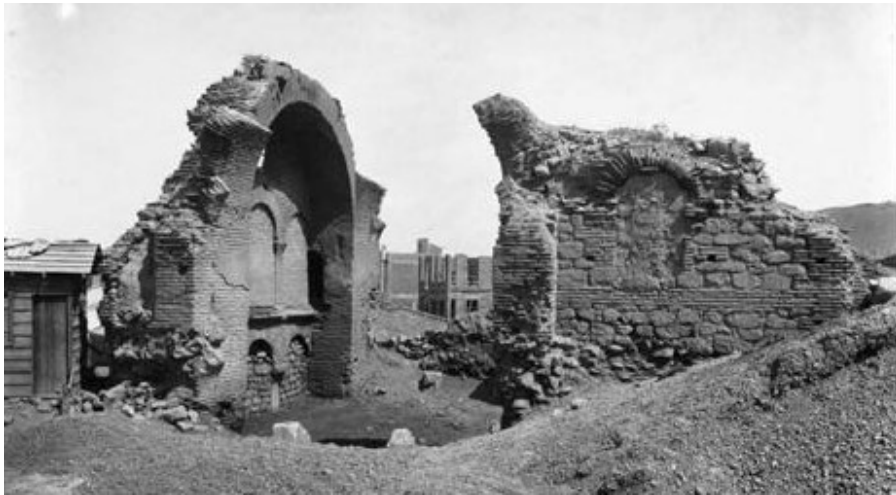
Şekil 74. Yapının 1917 yılındaki yangından sonraki durumunu (URL-27, 2023)
