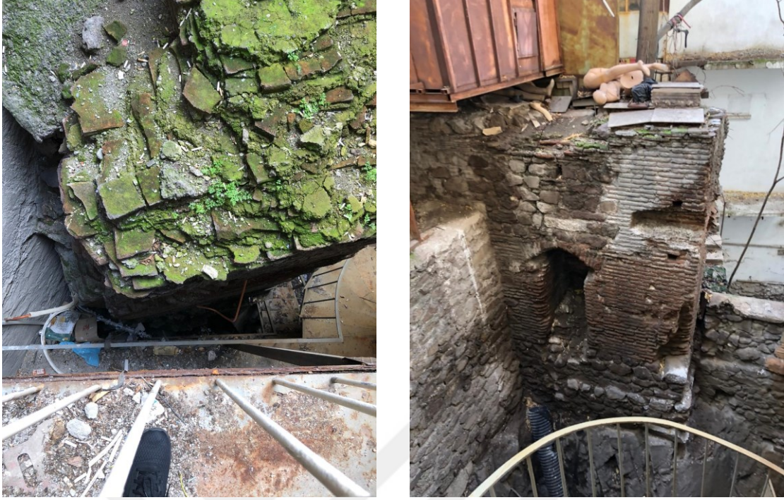
Şekil 64. Apsisin kuzey ve güney yönlerinde bulunan duvarların 2023 yılındaki durumu
