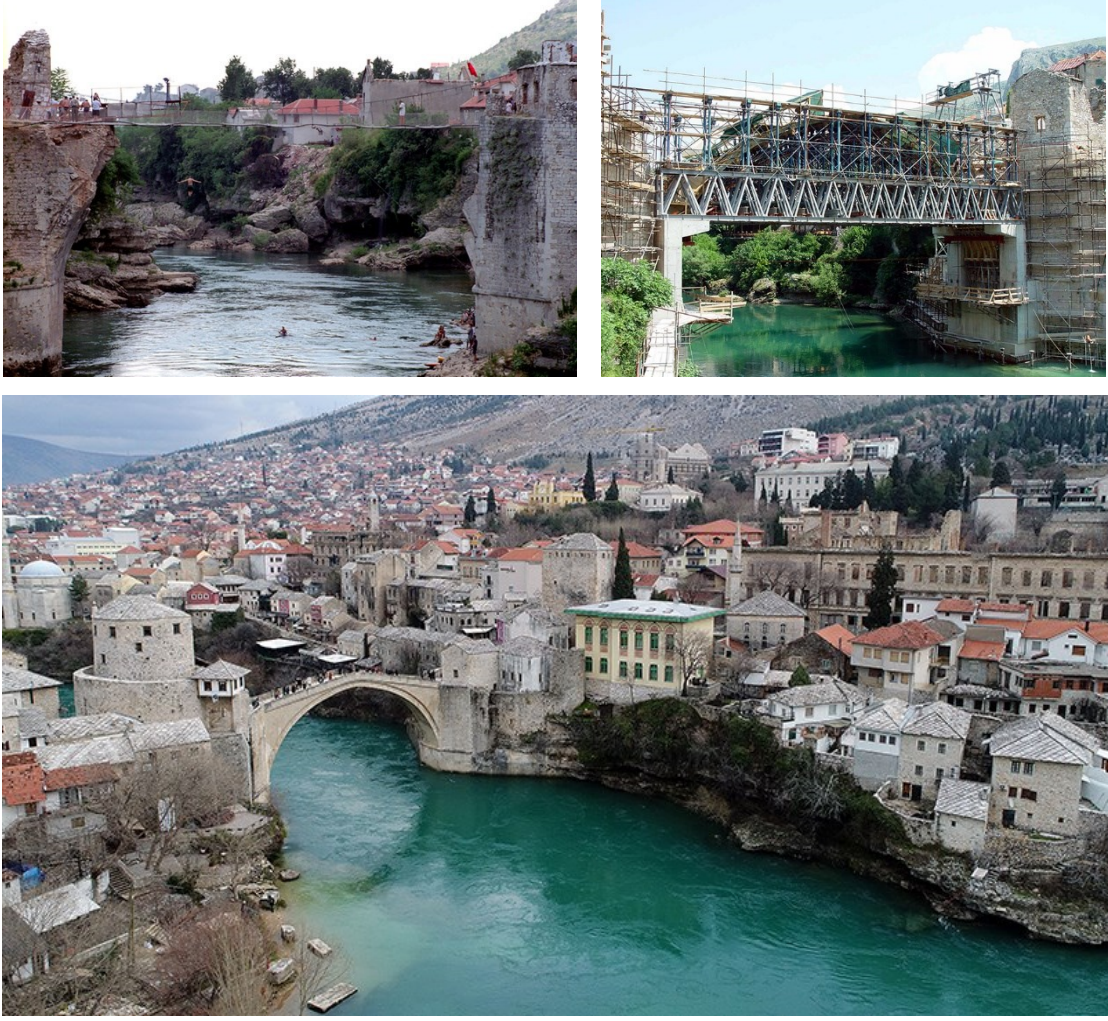
Şekil 5. Mostar Köprüsü'nün rekonstrüksiyon öncesi ve sonrası (Biogradlija, 2022)
