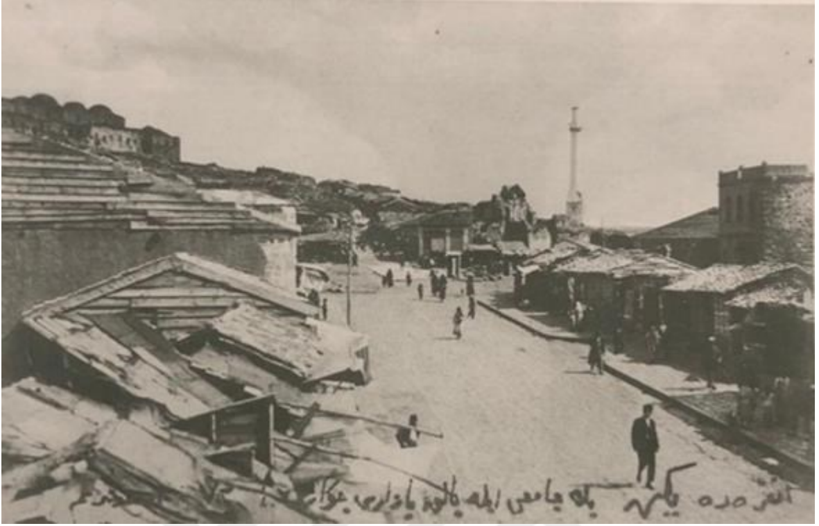
Şekil 67. 1924 yılına ait olan bir görsel, St. Klement Kilisesi'nin kalıntısı ve Yeğen Bey Cami'sinin hasarlı minaresi (Börtüçene, 1994)
