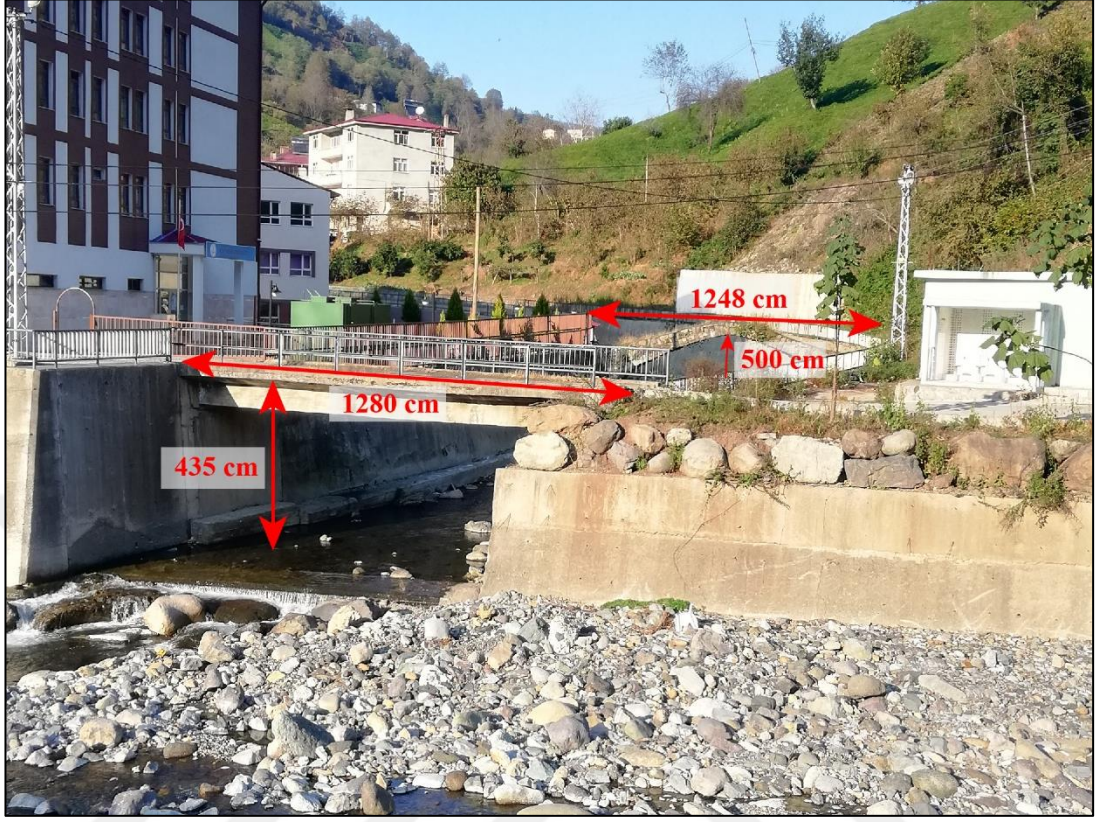
Fotoğraf 3.6: Hopa Yoldere Köyünde arka arkaya eski ve yeni köprü arasındaki fark.
