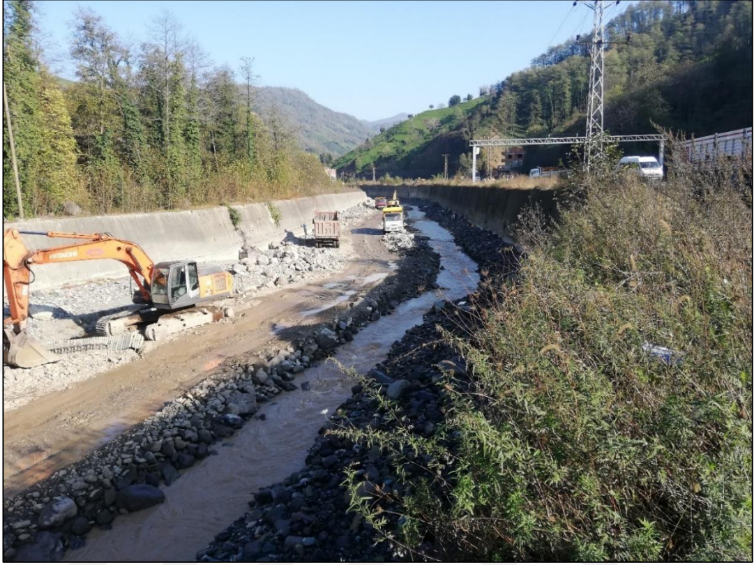
Fotoğraf 3.5: Hopa Çayı içerisinde iş makinesi çalışmaları.
