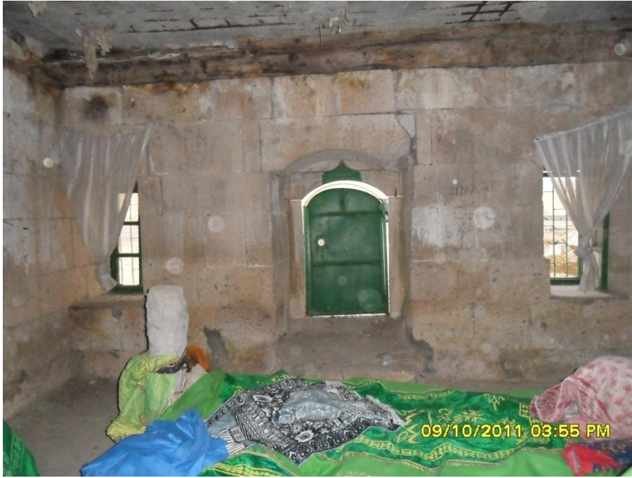
Resim 3.22. Türbe DV1 duvarı, Ekim 2011 [12]
