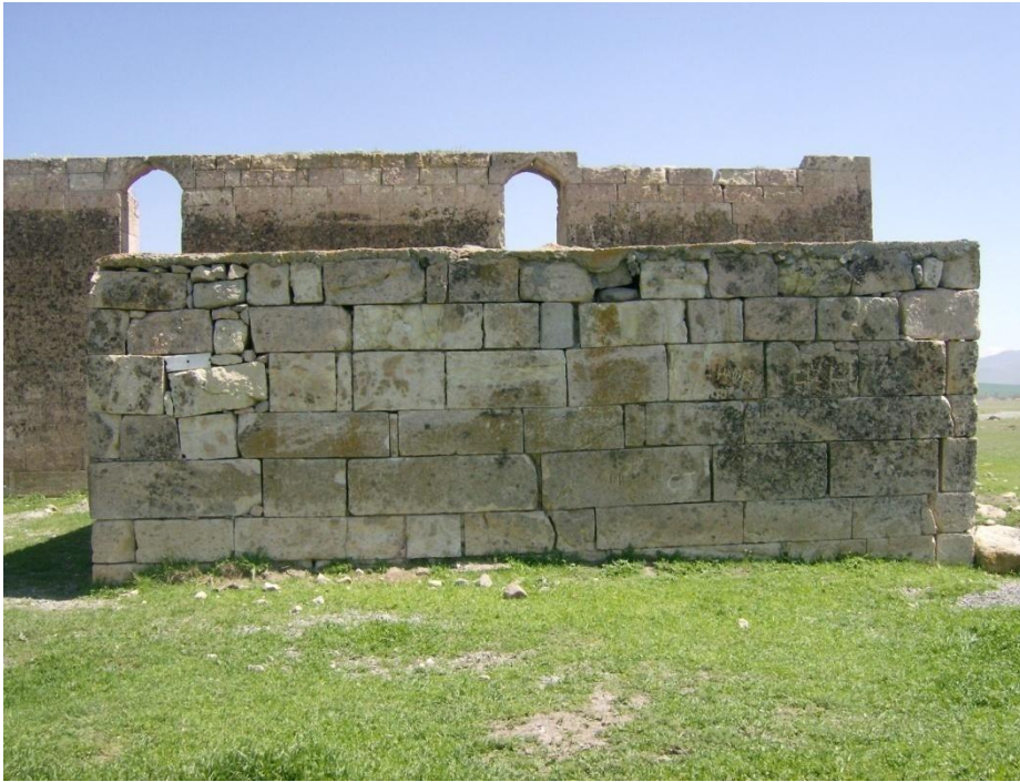
Resim 3.21. Tırbe kuzeydoğu görünüşü, Nisan 2010 [12]
