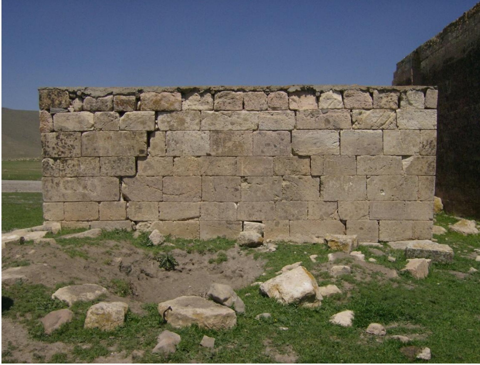
Resim 3.20. Tırbe kuzeydoğu görünüşü, Nisan 2010 [12]
